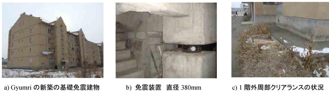
図 6.1-10 Gyumri の免震構造の集合住宅例
