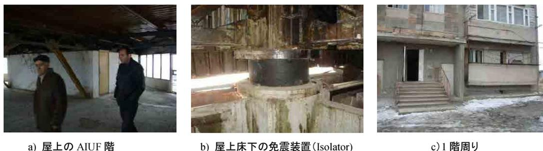
図 6.1-6 フレームパネル(9階建、型番 111)の屋上 Tuned Mass Damper (AIUF)
