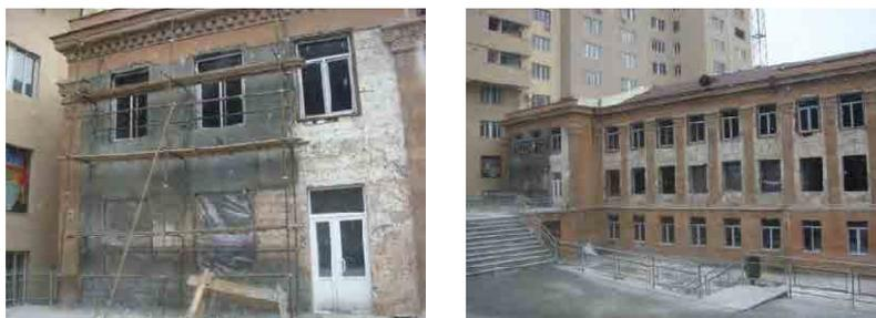
学校の耐震補強例(石造のジャケットイング、外壁に wire-mesh とモルタル) Kentron 区 No.29
