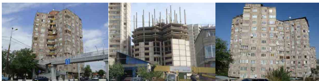
(左) Shengavit 区の 12 階建てシングルコアの建物
