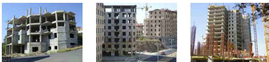
(左) Kentron 区北部の建設中の建物 (中) Kentron 区北部の建設中の建物 (右) 市内の建設中の建物
