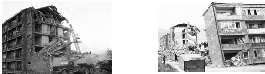
(a) Gyumri での建物側面の崩壊(NSSP EEC 提供) (b) Gyumri での中央部分の崩壊(NSSP EEC 提供)
