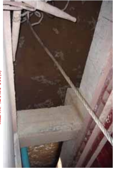
池底部梁、柱状況写真
