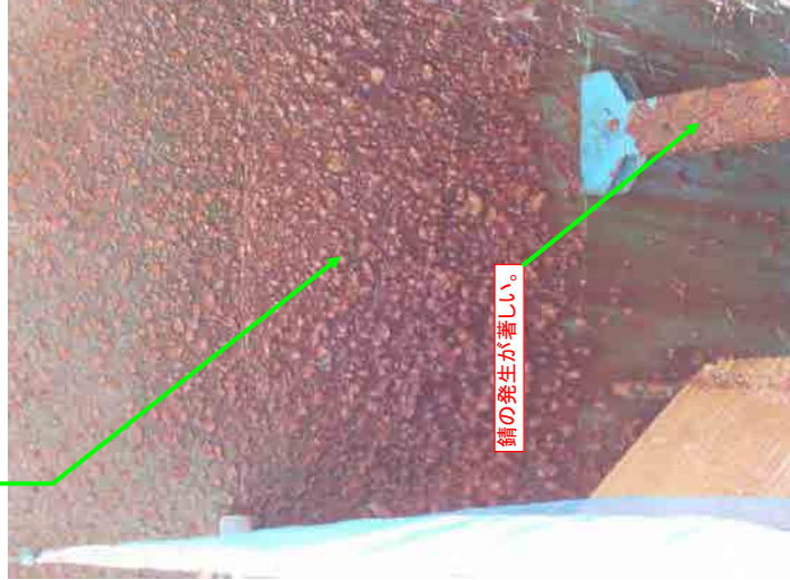
【沈蔵池壁補強桁状況】
