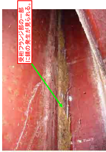
【沈澱池柱下部状況(ブロック1)】
