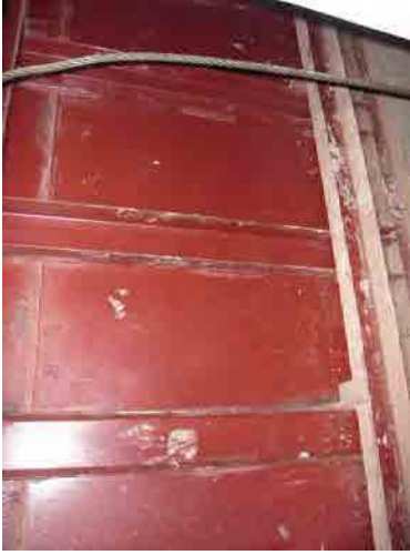
ブロック形成池上流部外面状況写真
