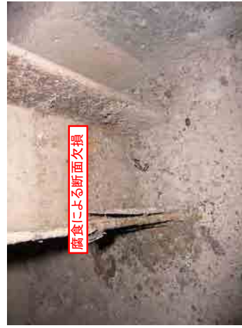
【沈澱池柱下部状況(ブロック1)】
