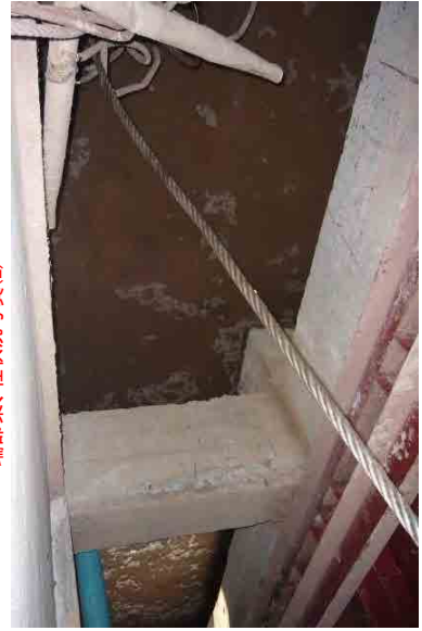
池底部梁、柱状況写真
