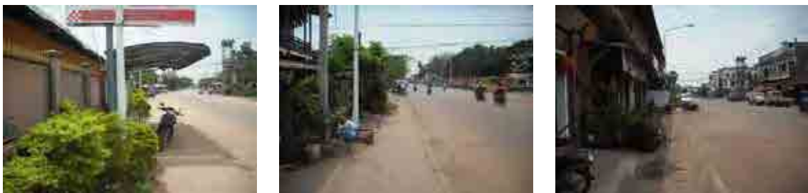
写真 3.2.2.4-3 市街地での管路布設予定位置の現況
