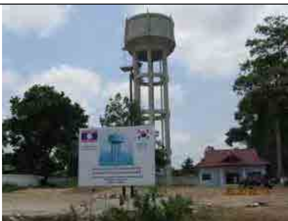
類似案件の状況 2：セーバンファイ地区高架タンク（KOICA の支援により建設された。）
