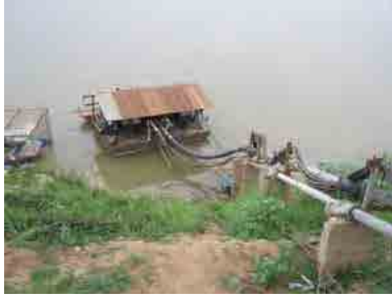
対象サイトの現状 1：既存の取水施設 (フローティング方式を用いているが、流木等の リスクがある。)
