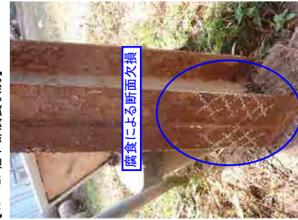
【1F~2F柱下部腐食状況】
