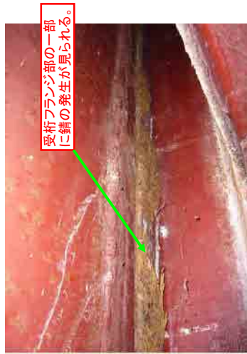
【沈蔵池柱下部状況(ブロック1)】
