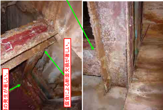
受桁5上流端及び底板状況写真
