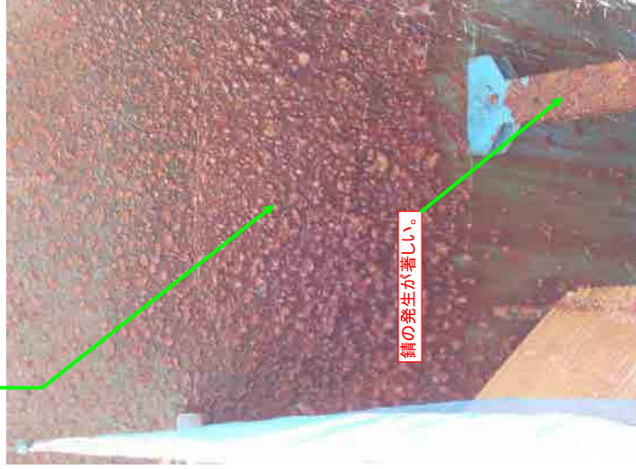
【沈蔵池壁補強桁状況】
