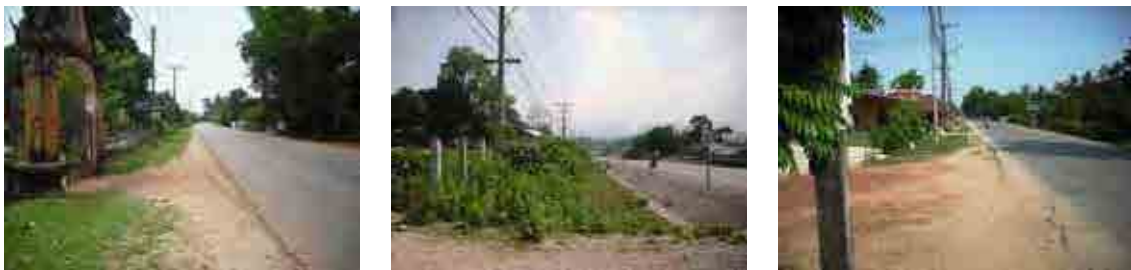
写真 3.2.2.4-1 一般的な管路布設予定位置の現況
