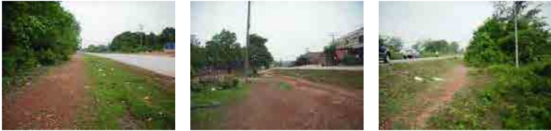
写真 3.2.2.4-2 国道 13 号線沿い管路布設予定位置の現況
