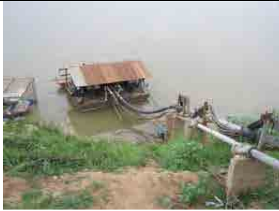
対象サイトの現状 1：既存の取水施設 (フローティング方式を用いているが、流木等の リスクがある。)
