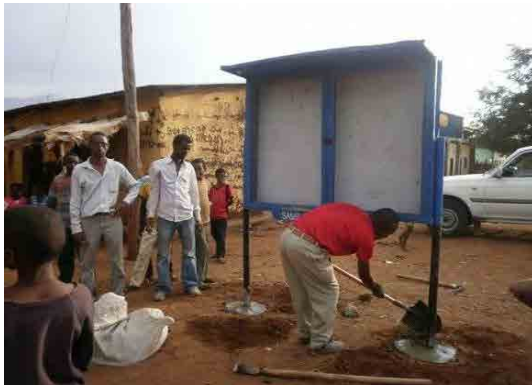
የገበያ ዋጋ የማስታወቂያ ቦርድ ለወረዳዎች ተሰጥቷል
