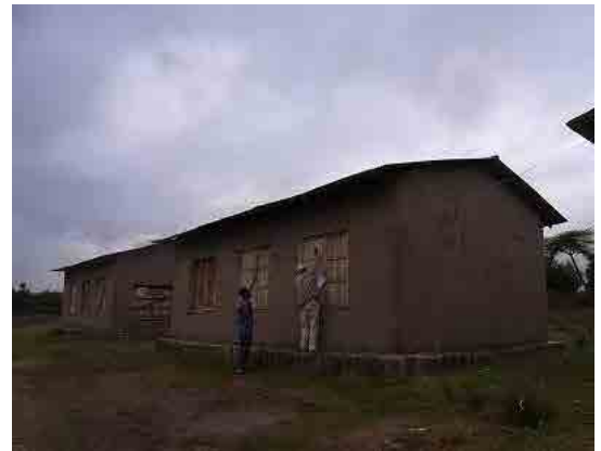
ሀንጣጤና ሕ/ሥራ፣ ሎኮ አባያ ወረዳ፣ ከቀበሌ የተከራየው 2 መጋዘን 1 በርና 6 መስኮት ያለው
