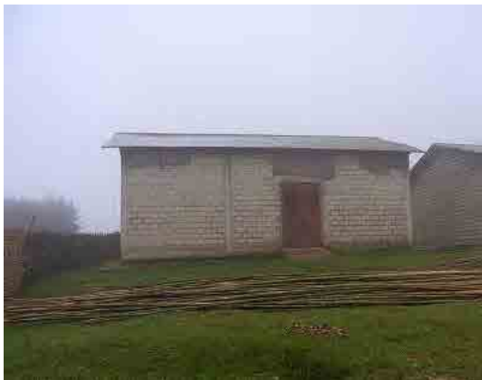
አበላ ሕ/ሥራ ማህበር፣ ሁላ ወረዳ ንፋስ ማሰጠያ ያለው መጋዘን፣ ከተሠራ 20 ዓመት ይሆናል፣ በሥራ ላይ ይገኛል። 200 ቶን አያንዳዱ ይይዛል.
