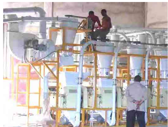
製粉機の調整作業
