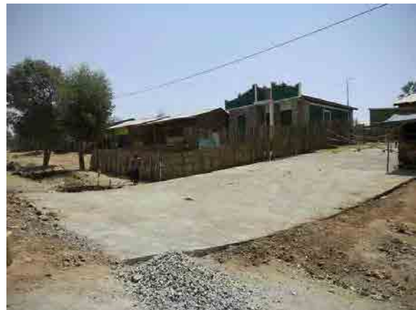
浅瀬式排水溝横断工 (11 Jul. 2011)
