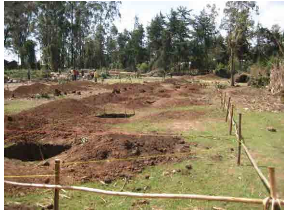
倉庫基礎掘削 (2011/3/23)
