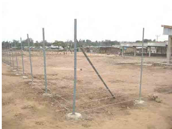
フェンス工事 (11 Jul. 2011)
