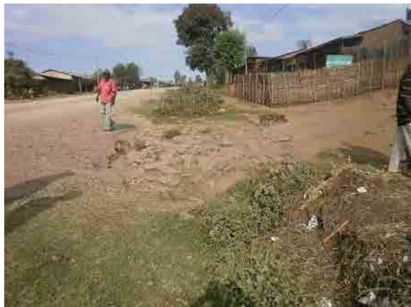
施工前の状況 (01 Nov. 2011)
