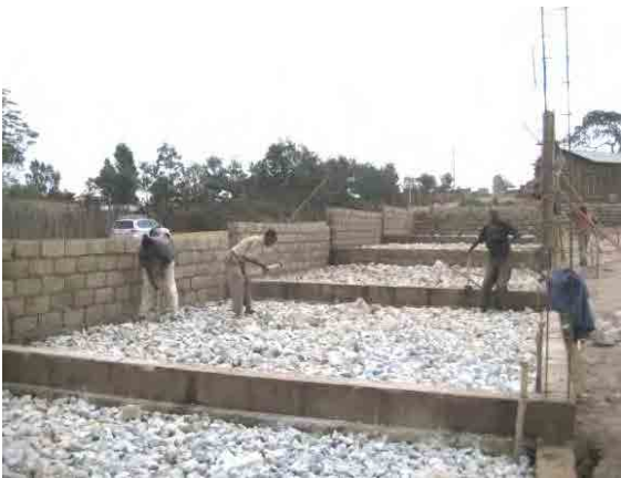
基礎栗石及びブロック工事 (05 Apr. 2011)
