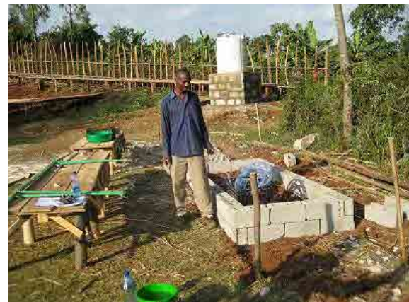
左官技能をもつメンバーが暫定的に用いる浸漬槽を作製
