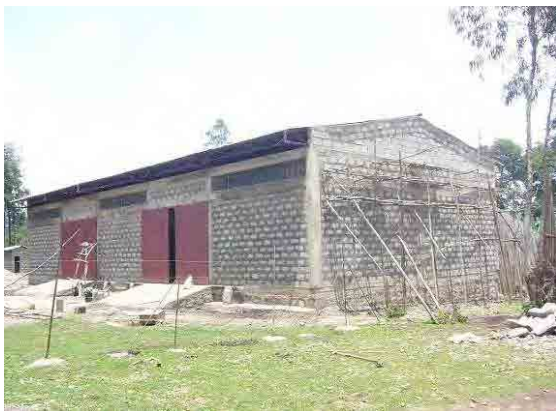
屋根葺き・スライドドア工事 (2011/7/22)
