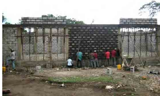
ブロック積・上部梁工事 (2011/6/9)
