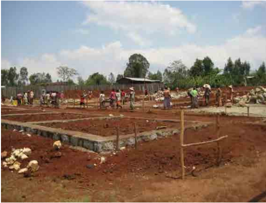
石積み基礎工 (07 Apr. 2011)
