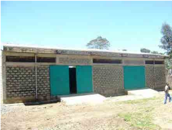
アンガチャ農協ユニオンに建設された 500 トン穀物倉庫 (PP08)
