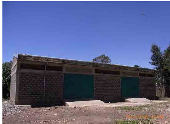
工事完了後の様子(2012/10/21)
