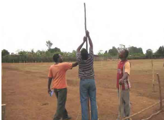
測量及びくい打ち (03 Mar. 2011)
