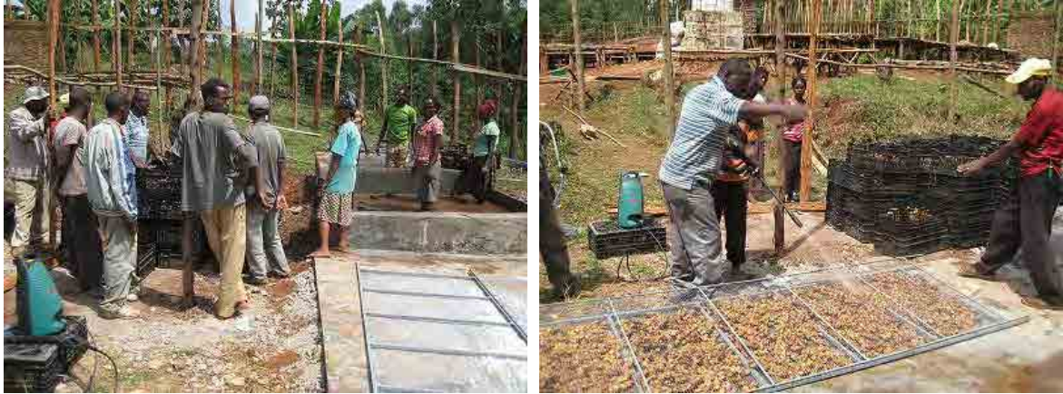
Hadaro サイトでの訓練（労務者に対する作業指示）
