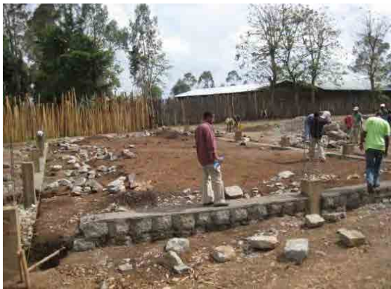
石積み基礎工事 (2011/4/7)
