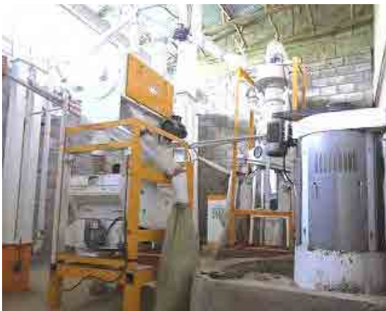
クリーナー、ピーター、石抜機、加水機
