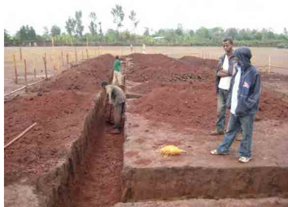
基礎トレンチ掘削 (15 Mar. 2011)
