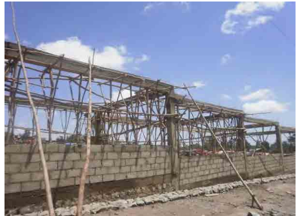
屋根工事 (05 May 2011)
