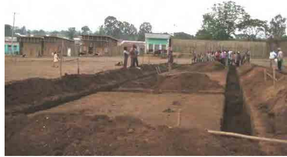
基礎トレンチ掘削 (16 Mar. 2011)
