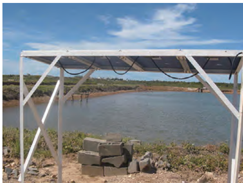
Antshanibingo 養殖場に作った簡易太陽光発電システム。停電が多いこの地区で24時間給電が必要な餌料試験室に給電する工夫である。
