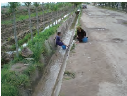
施設敷地前面道路沿いの用水路。取水源となっている。
