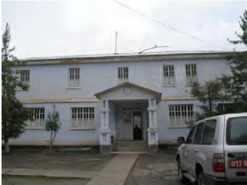
正面外観。病院とHCが混在している。
