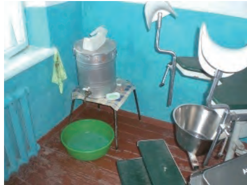
施設内部。汲み置き式の水タンクと排水受けのポリ洗面器
