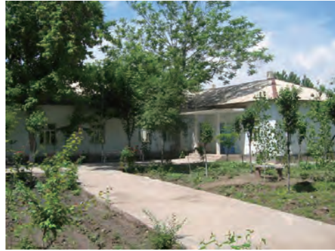
産科棟。建物の半分は管理部門が使用
