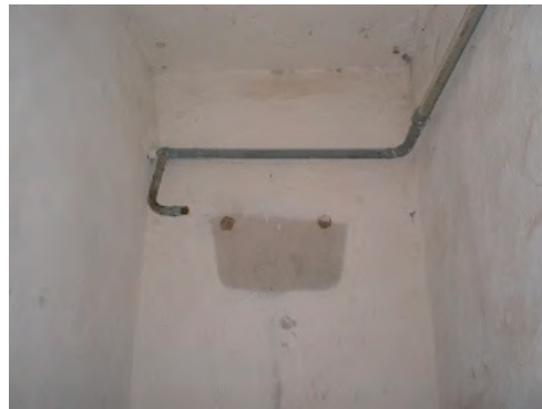
施設内のトイレ跡。シスターンクスの痕跡が残る。
