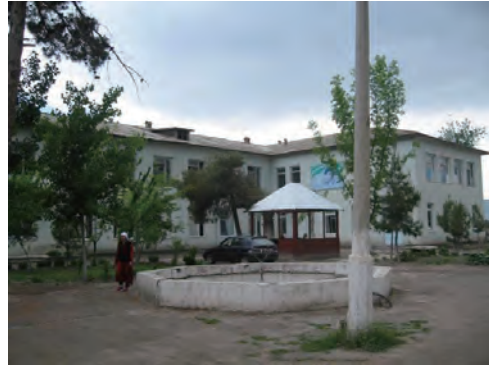
産科棟西側外観。1、2階とも産科が使用
