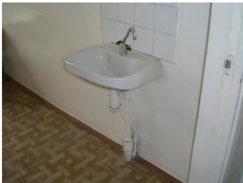
施設内の洗面器。給排水はないが、器具、配管等の状態は比較的良い。
