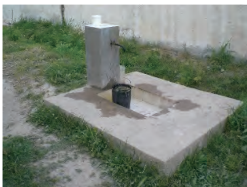
2011年にNGOによって整備された構内の共同水栓。同施設の水源である。
