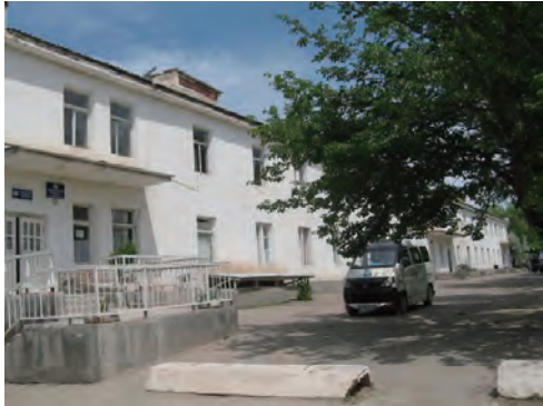
正面外観。左側にある1階入口はHCの入口
