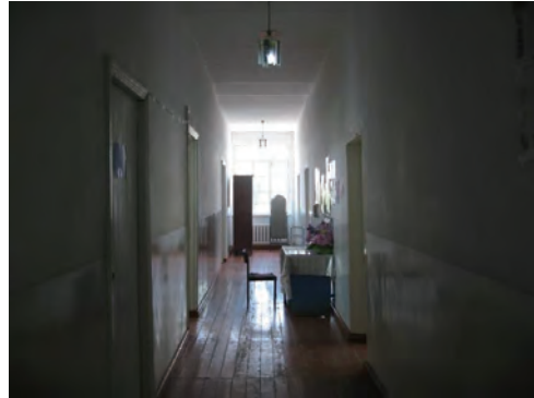
中廊下。きれいに使用している。
