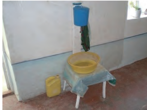
施設で使用されている手作り洗面台。給水は上部のポリタンクから引いている。
