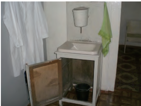
亜鉛メッキ銅板製の給水タンクと洗面台、なかに排水受けのポリバケツが見える。
