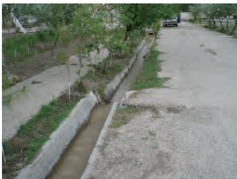
施設敷地全面の用水路。取水源である。
