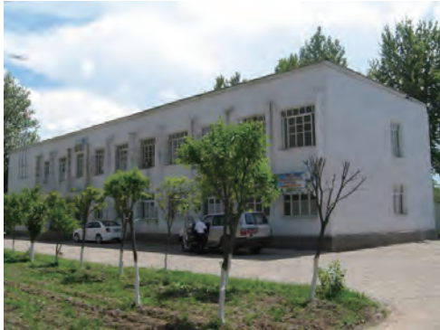
病院外観。1階の半分はヘルスセンター（HC）として使用
