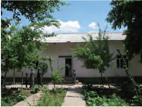
小児、内科棟。敷地内にある3棟のうちの一つ
