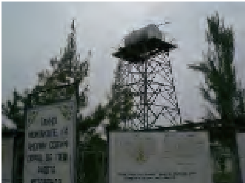
構内の高架水槽、現在は外科病棟のみに給水している。
