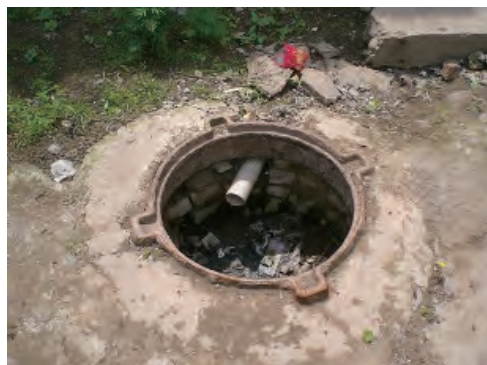
構内の排水マンホール
