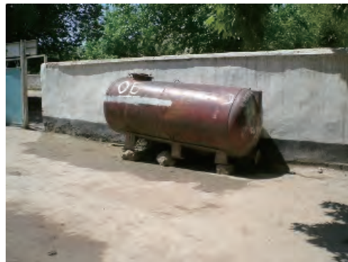
構内の受水タンク。給水時間中に水栓からホースで水を入れる。
