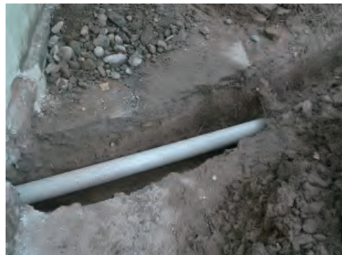
左同。施工中の屋外埋設排水管
