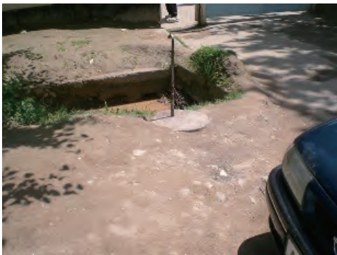
敷地正門前にある共同水栓。同施設の水源である。
