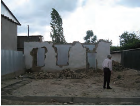
壁だけを残して大規模改修中
