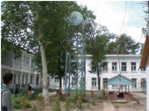
既存の高架水槽。本体、給水管等にクラックがあるが修復は可能
