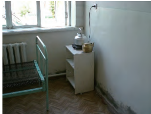
病室。給排水設備は全くない。
