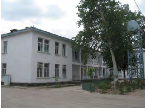
本館東側外観。2階部分を産科部門で使用。右側に1998年UNDPの資金で設置された高架水槽がある。
