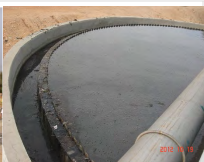
Photo 4-29 Réservoir d'épaississement 1
