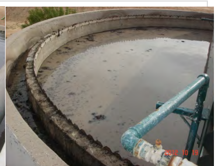
Photo 4-30 Réservoir d'épaississement 2
