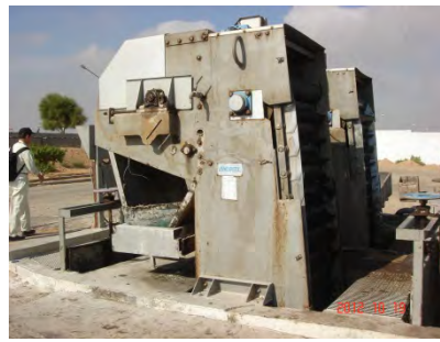
Photo 4-5 Dégrilleur mécanique 2
