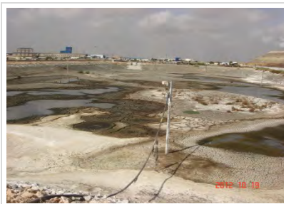
Photo 4-13 Bassin d'anaérobie 1A
