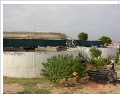
Photo 4-28 Vue d'ensemble de réservoir d'épaississement
