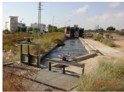
Photo 4-2 Canal de dégazage 2
