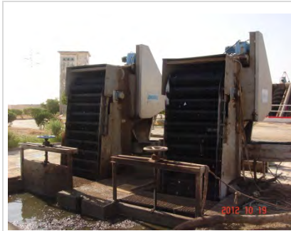
Photo 4-4 Dégrilleur mécanique 1
