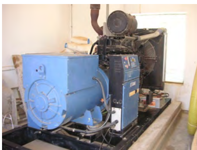
Photo 4-59 Groupe électrogène
