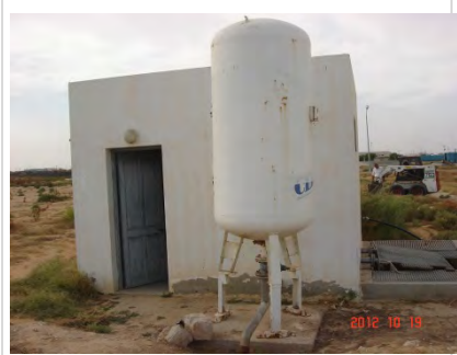
Photo 4-40 Bâtiment de pompe d'eau d'usine
