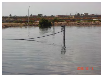
Photo 4-14 bassin d'anaérobie 2A
