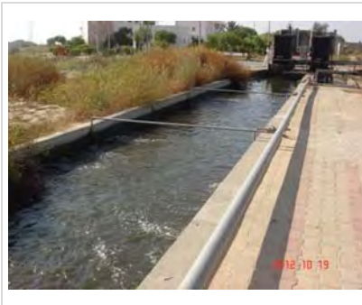
Photo 4-1 Canal de dégazage 1
