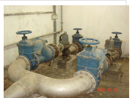
Photo 4-27 Pompe de boue en surplus
