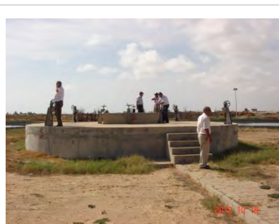
Photo 4-20 Fosse d'évacuation de la boue
