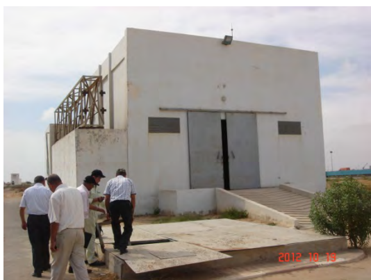
返送汚泥ポンプ棟
