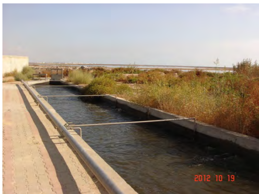
ガス抜き水路
