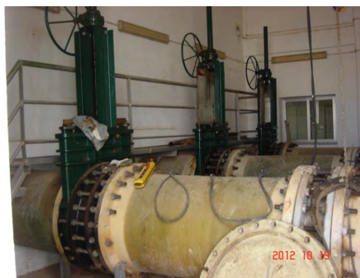
返送汚泥ポンプ棟
