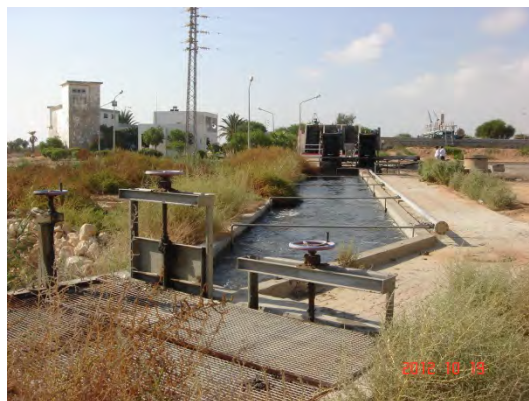
ガス抜き水路
