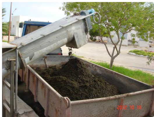
砂・油脂除去施設
