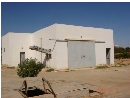
機械脱水機棟
