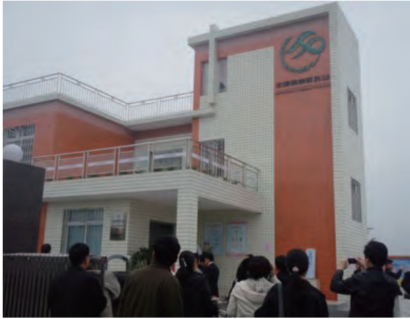
モデル区の家庭保健サービスセンター（重慶市永川区）：自己負担により、新たに建設された。
