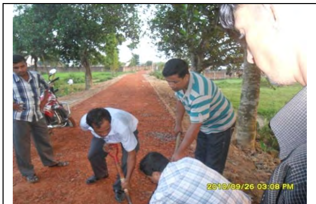
Sripur Pourashava Road
