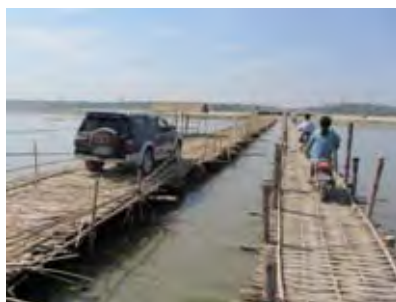
被災地における仮設橋 (Pauk Township) (photo: study team)
