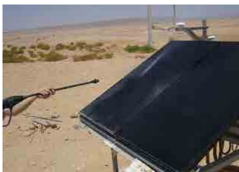
図 5-2-3 高圧水による清掃状況
