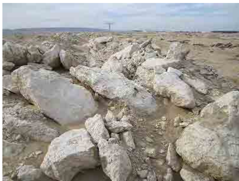
写真 3-1-4-4 工事現場から撤去された岩
