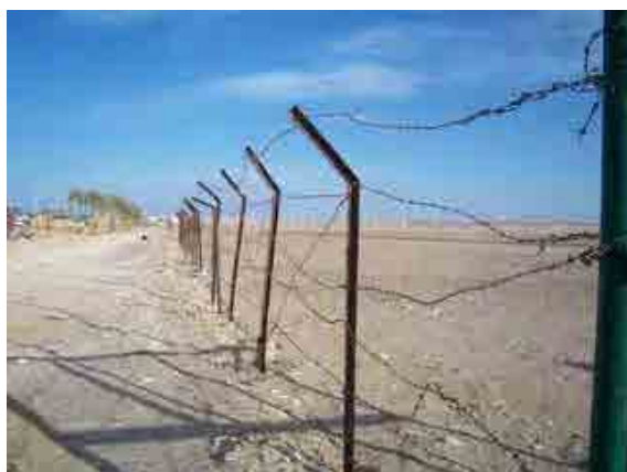
写真 3-1-1-11 既設現地境界フェンス (11)
