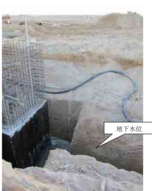
写真 3-1-4-6 工事現場における地下水位の状況
