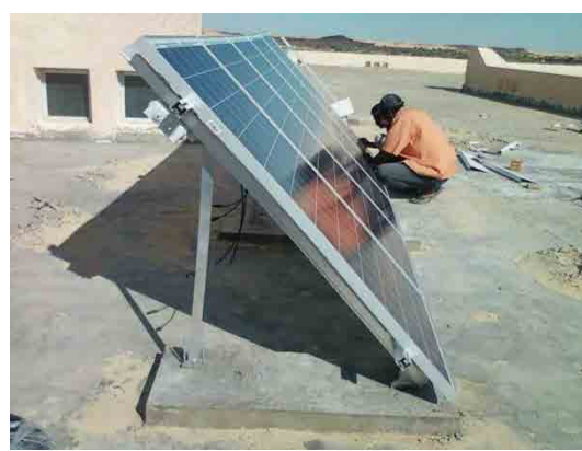
写真 2-2-11 村落電化プロジェクト2
