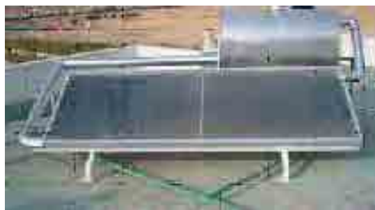
写真 2-2-7 メディカルセンターにおける 太陽熱温水パネル: 2008 出展: EEHC 年次報告書 (2009/2010)
