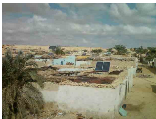
写真 2-2-10 村落電化プロジェクト1
