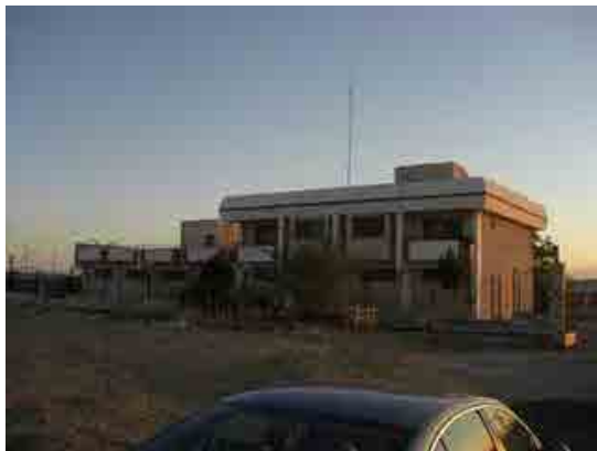
写真 3-1-2-1 ハルガダ風力発電所内の 配電会社所有の配電所
