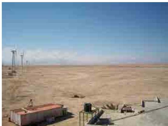
写真 3-1-1-1 北側の現地状況 (1)
