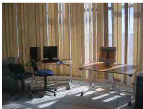
写真 3-1-1-6 既設風力発電用 SCADA システム (6)
