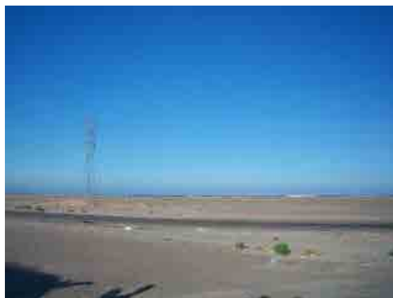
写真 3-1-2-5 近傍の架空 66kV 送電線 /中央ハルガダ変電所からゴウナ変電所 (運用開始前)
