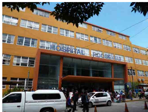
ルーズベルト病院外観
