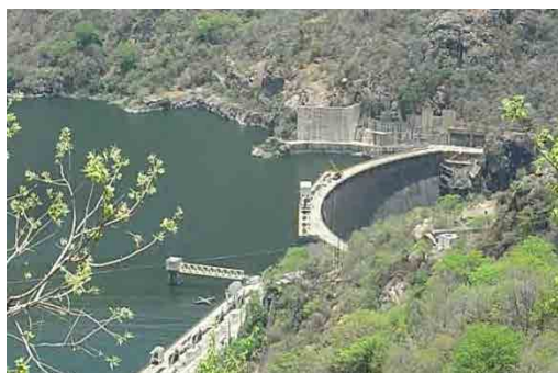
写真 5-4-1 カオラバッサ水力発電所
