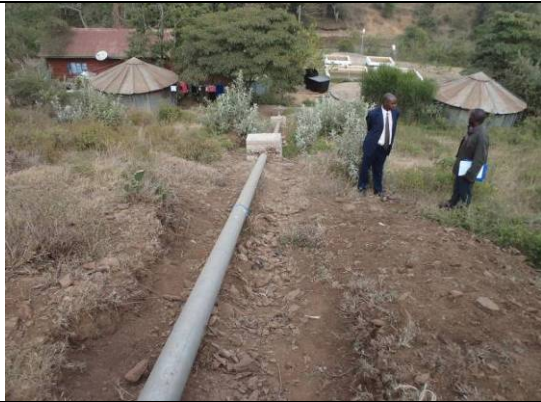
写真-13：送水管 (露出管×1条の下に埋設管×1条)
