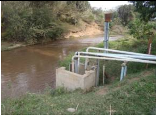
写真-1：既設取水口（中部浄水場内）
