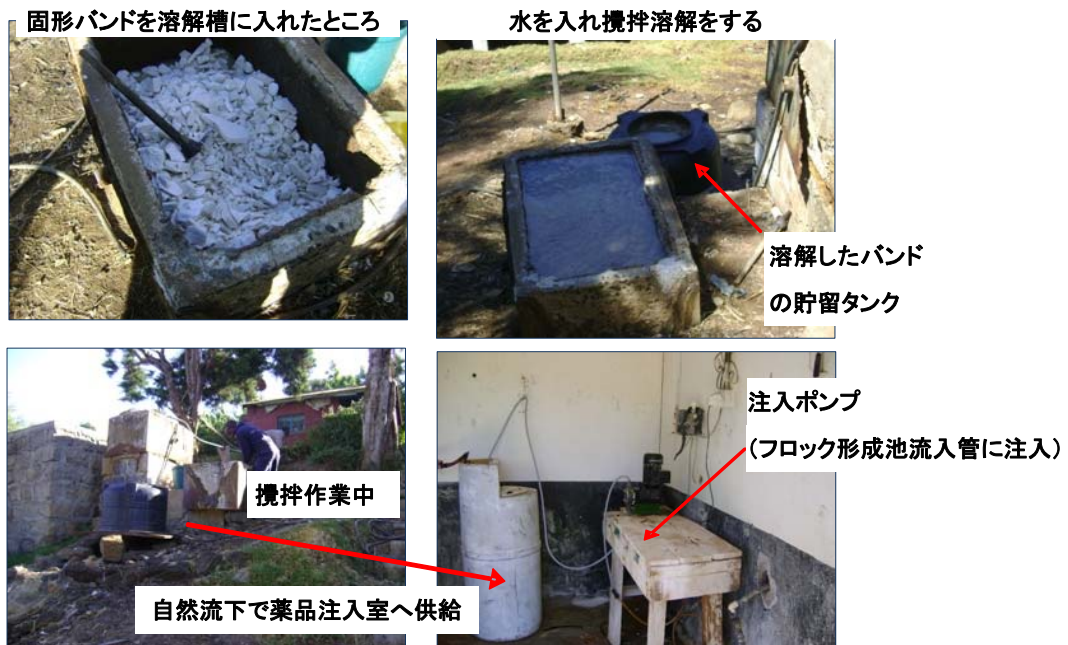
写真 2-1-8 硫酸バンド注入作業状況
