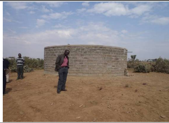
写真-14：配水池 (Block 11)
