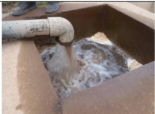
写真-5：中部浄水場・着水井（フェーズ3施設）
