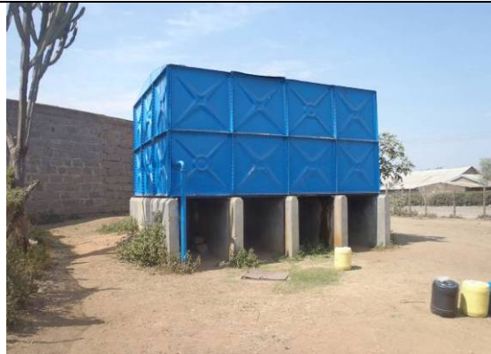
写真-15：配水池 (マジェンゴ地区)
