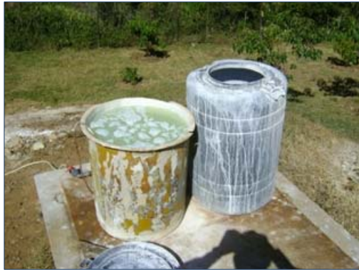
写真 2-1-7 次亜塩素酸カルシウム注入設備
