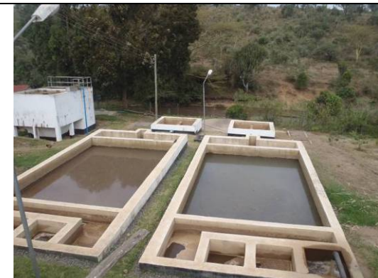
写真-6：中部浄水場 沈殿池（フェーズ3施設）
