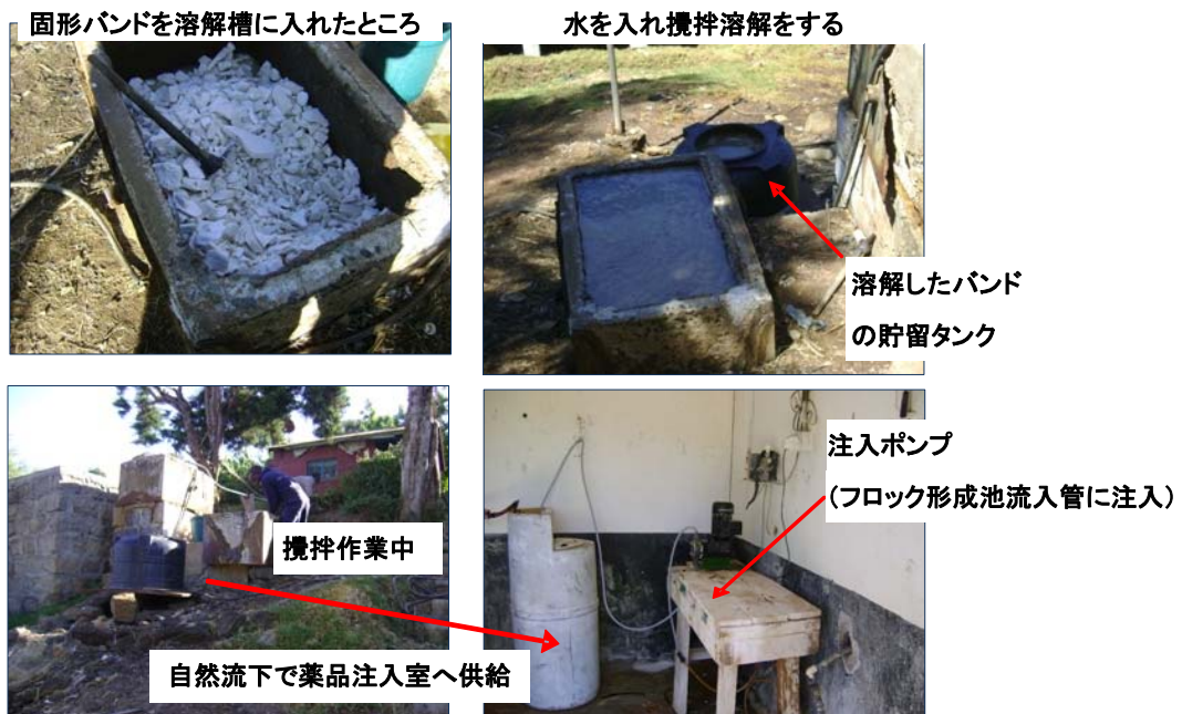
写真 2-1-8 硫酸バンド注入作業状況
