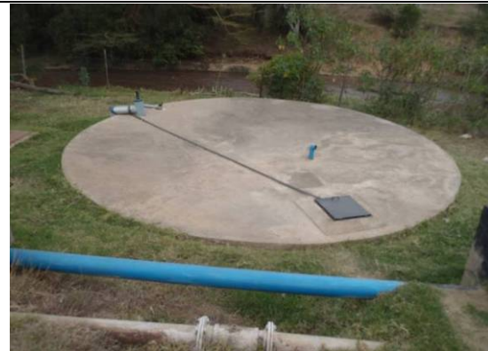
写真-8：中部浄水場 浄水池 （フェーズ3施設, V=100m 3 ）
