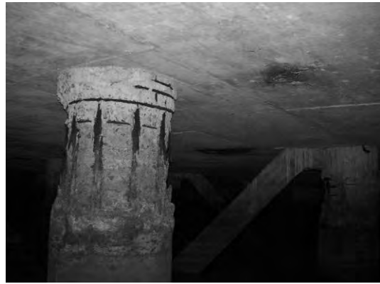
Block 2 Pile 30D ~ 30E
