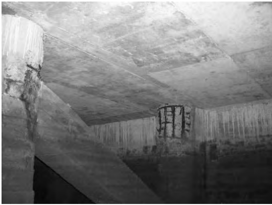
Block 2 Pile 20A
