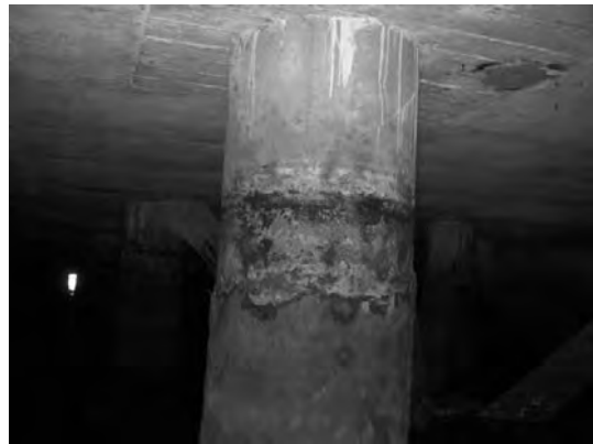
Block 3 Pile 60C
