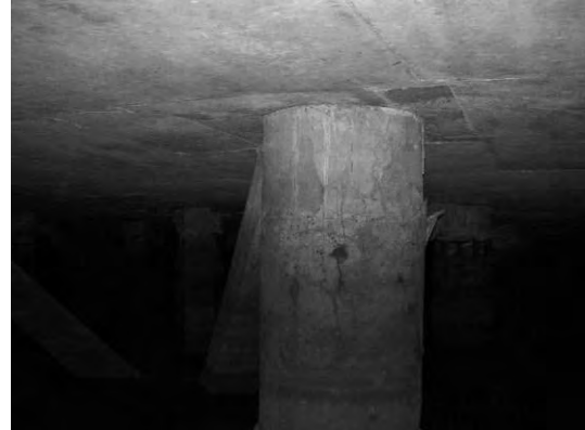
Block 2 Pile 39E
