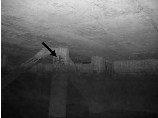
Block 2 Pile 30A ~ 30B
