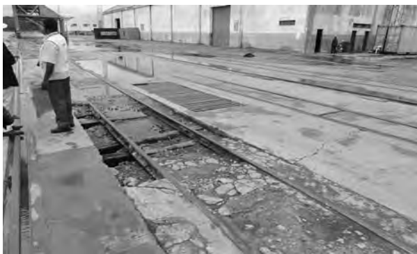
写真-3 北埠頭上部工状況
