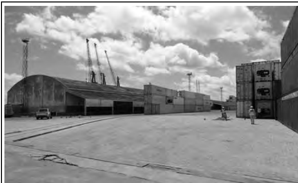
写真-9 コンテナヤード予定地状況
