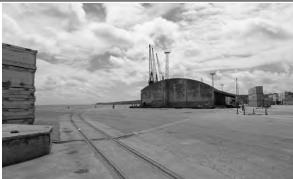
写真-7 コンテナヤード予定地状況
