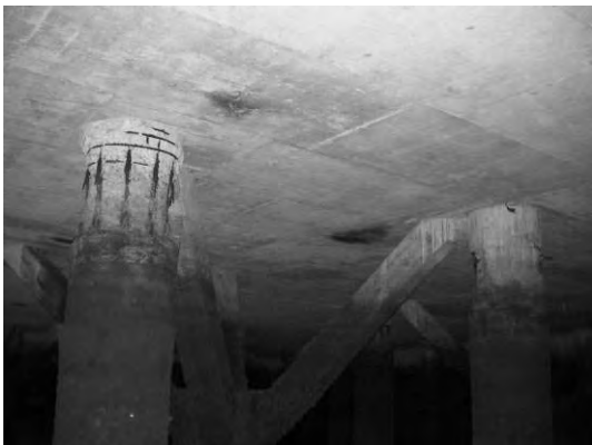
Block 2 Pile 30D ~ 30E
