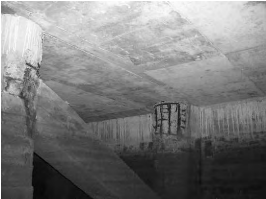
Block 2 Pile 20A
