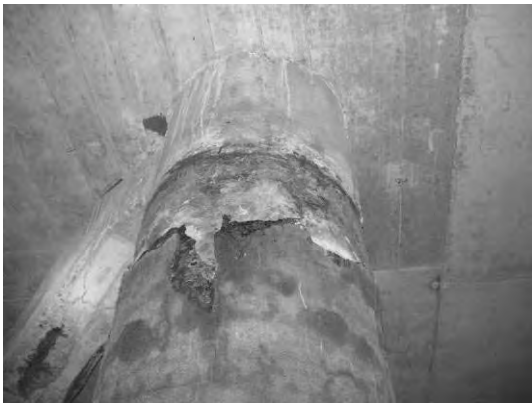
Block 3 Pile 60C
