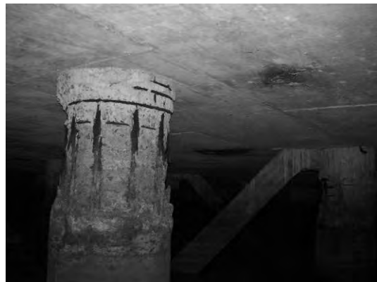
Block 2 Pile 30D ~ 30E
