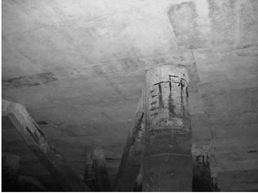
Block 3 Pile 43E
