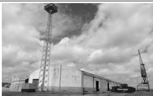
写真-10 コンテナヤード予定地状況
