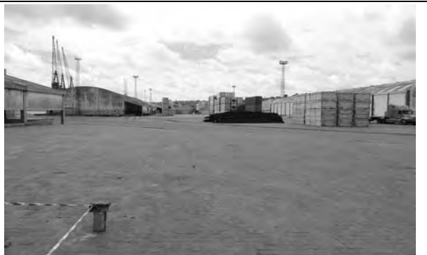
写真-8 コンテナヤード予定地状況
