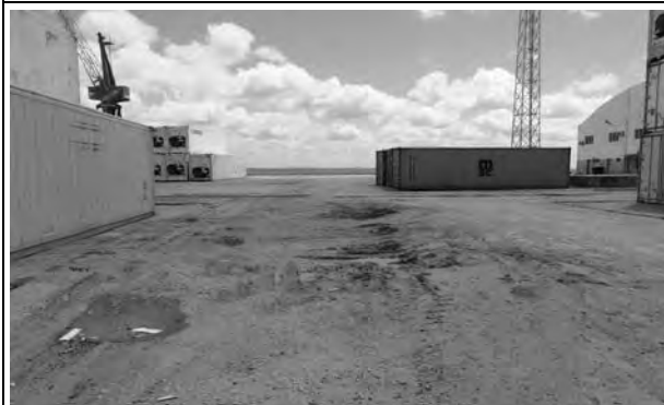
写真-11 コンテナヤード予定地状況
