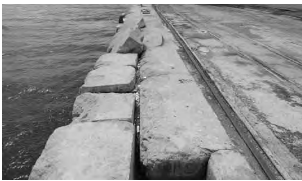
写真-1 北埠頭上部工状況
