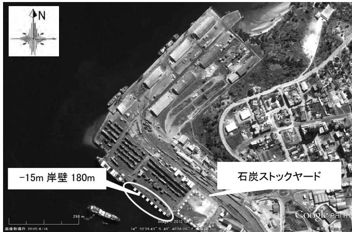
図 3.1.1-4 Vale 社の使用する港湾施設
