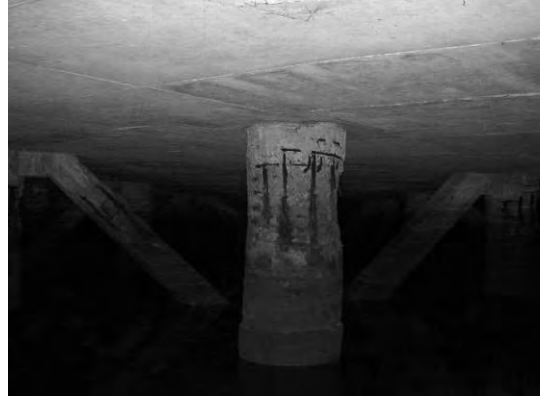
Block 3 Pile 43E
