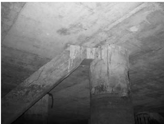
Block 2 Pile 20E
