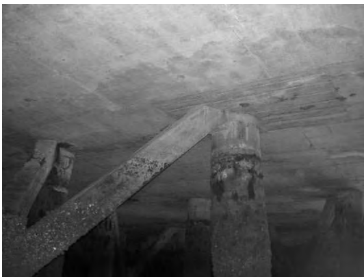
Block 3 Pile 60E
