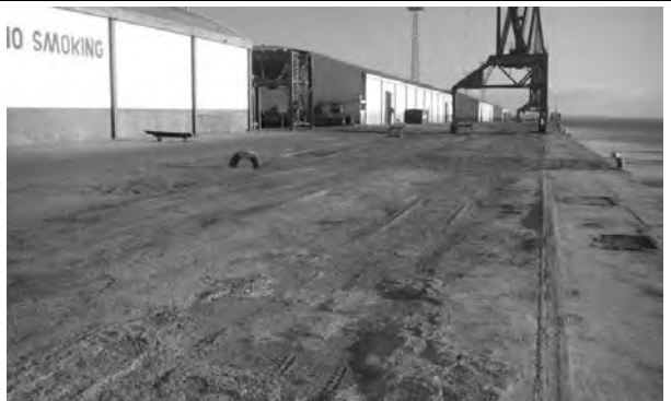
写真-6 北埠頭エプロン状況
