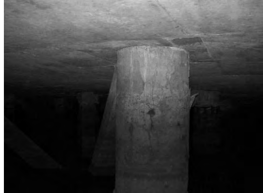
Block 2 Pile 39E
