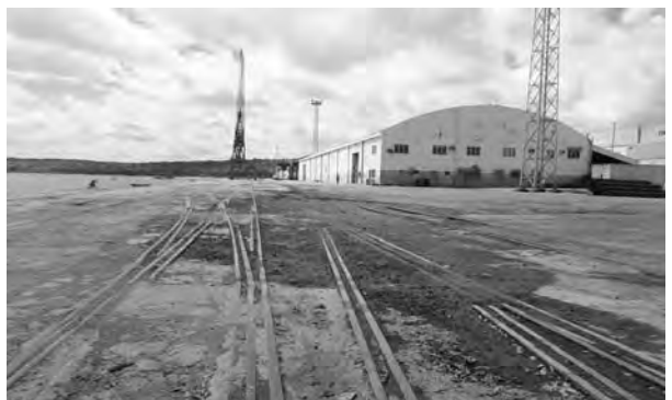
写真-4 北埠頭エプロン状況
