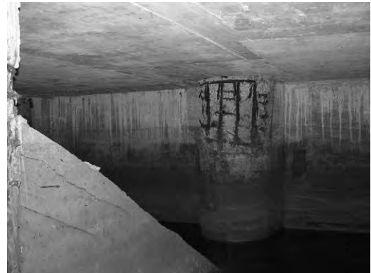
Block 2 Pile 20A
