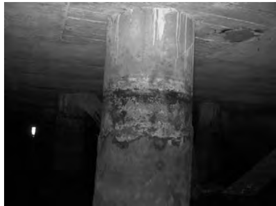
Block 3 Pile 60C
