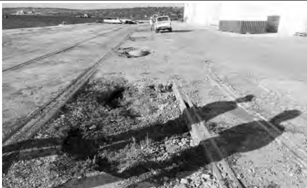
写真-5 北埠頭エプロン状況
