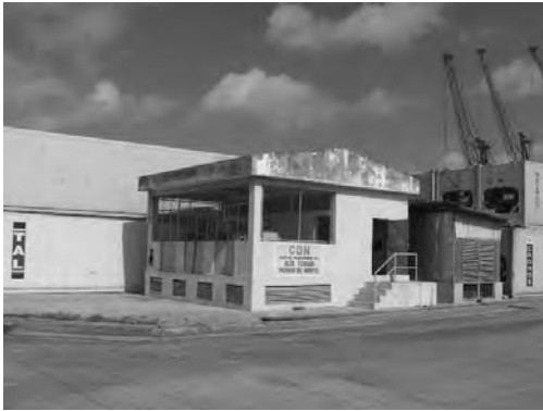
図 2.1.4-7 北埠頭2番倉庫背後にある変電所
