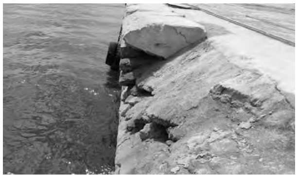
写真-2 北埠頭上部工状況
