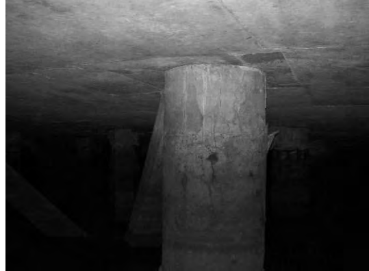
Block 2 Pile 39E
