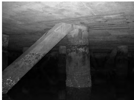
Block 3 Pile 60E
