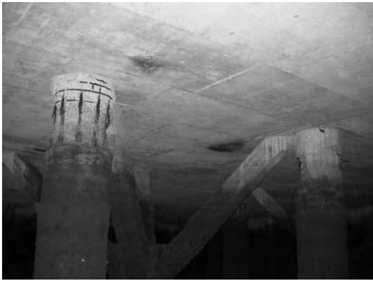
Block 2 Pile 30D ~ 30E
