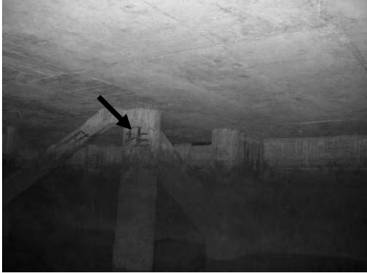
Block 2 Pile 30A ~ 30B
