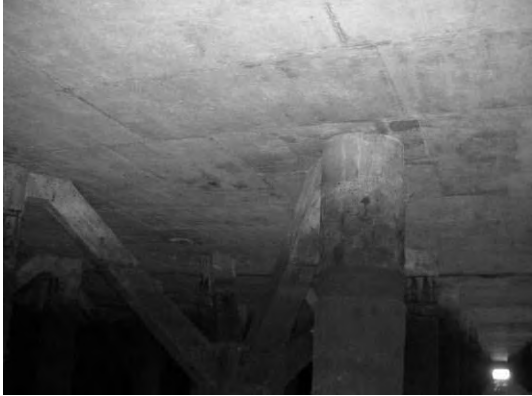
Block 2 Pile 39E
