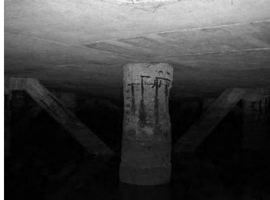
Block 3 Pile 43E
