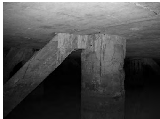
Block 2 Pile 20E
