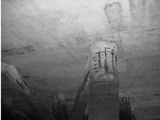
Block 3 Pile 43E
