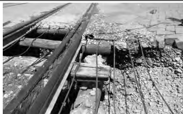
写真-12 コンテナヤード予定地状況
