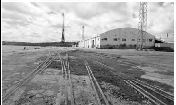
写真-4 北埠頭エプロン状況
