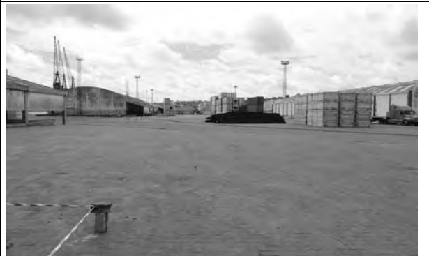
写真-8 コンテナヤード予定地状況
