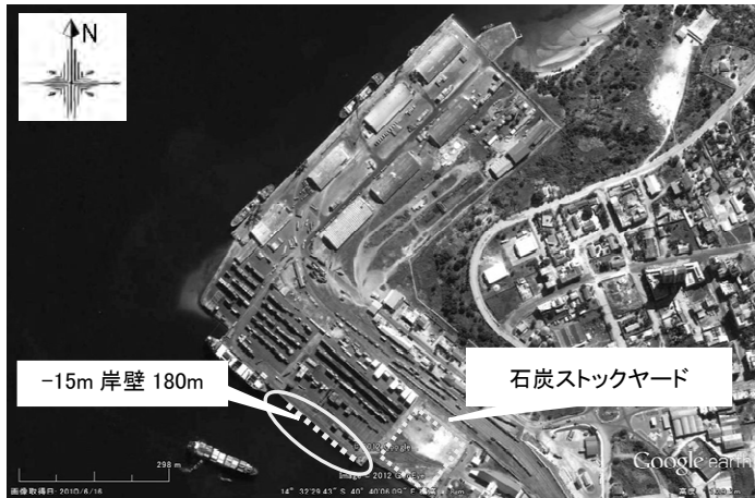
図 3.1.1-4 Vale 社の使用する港湾施設
