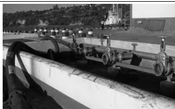
写真-14 既設オイル荷役設備
