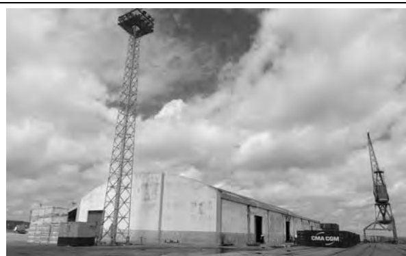
写真-10 コンテナヤード予定地状況
