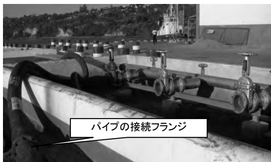
図 3.1.2-6 液体バルク荷役用パイプとバルブ 図 3.1.2-7 本船と荷役施設との接続作業
