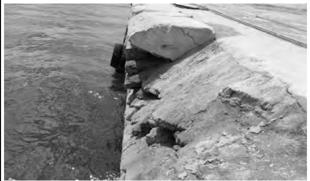
写真-2 北埠頭上部工状況
