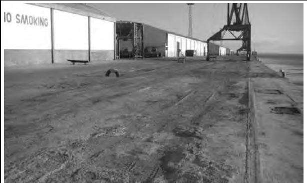
写真-6 北埠頭エプロン状況
