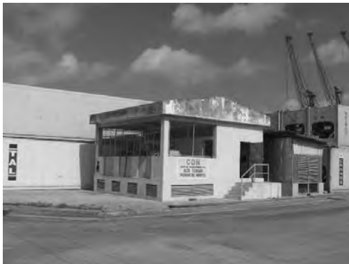
図 2.1.4-7 北埠頭2番倉庫背後にある変電所
