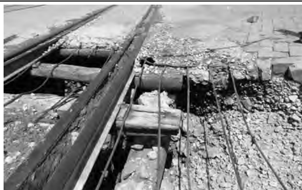
写真-12 コンテナヤード予定地状況
