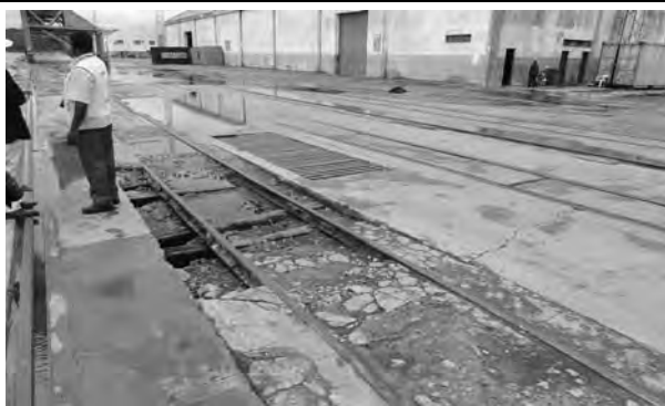
写真-3 北埠頭上部工状況
