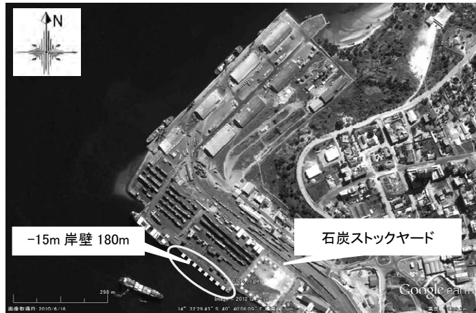
図 3.1.1-4 Vale 社の使用する港湾施設
