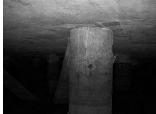
Block 2 Pile 39E
