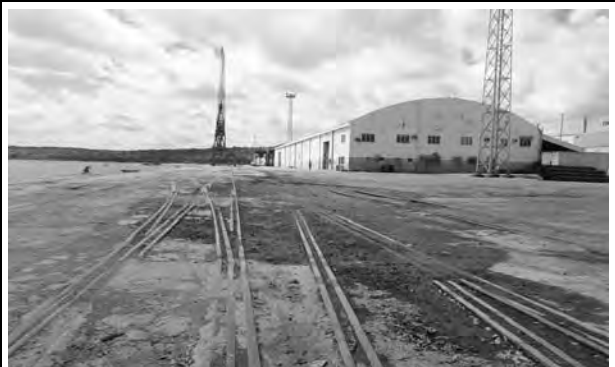
写真-4 北埠頭エプロン状況
