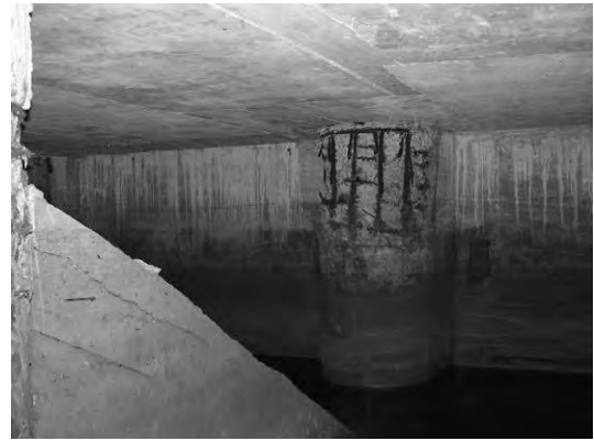
Block 2 Pile 20A
