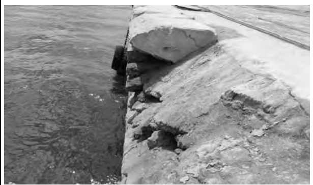
写真-2 北埠頭上部工状況
