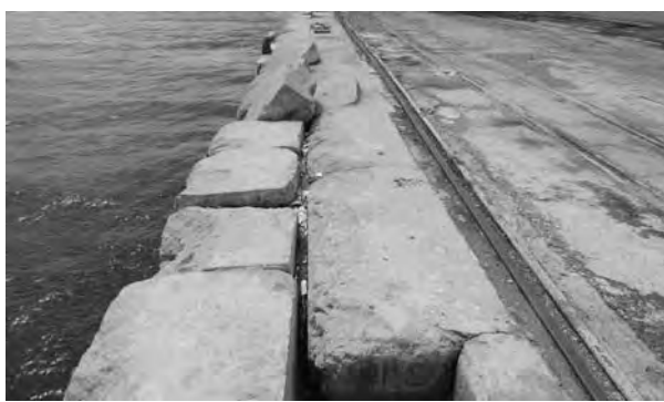
写真-1 北埠頭上部工状況
