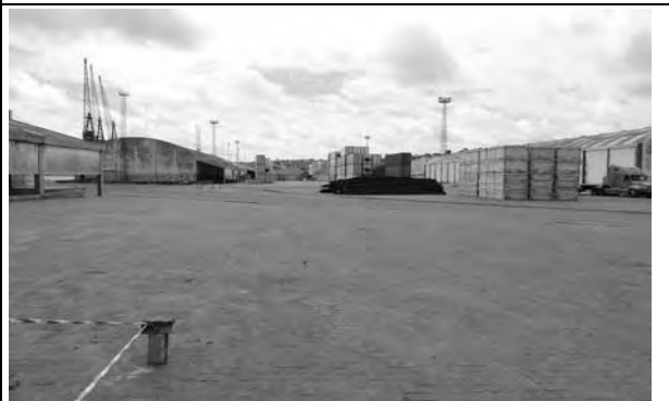
写真-8 コンテナヤード予定地状況
