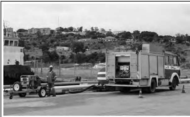
写真-17 既設消火設備
