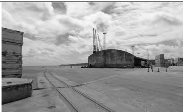
写真-7 コンテナヤード予定地状況
