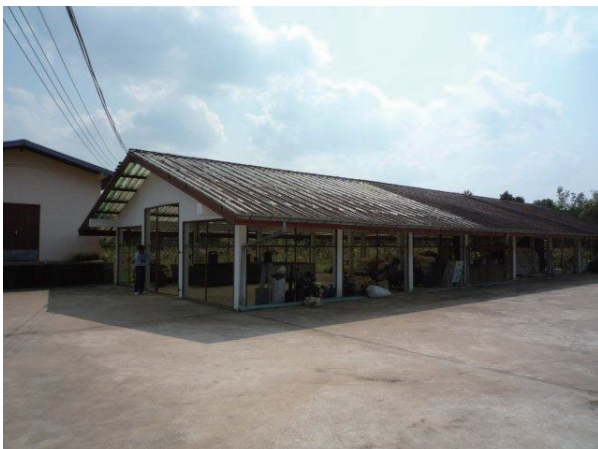
本プロジェクトにより整備したパクチェン農業ステーションの作業場と乾燥場
