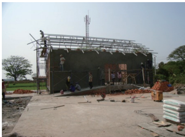
ノンヘオ種子増殖センターの建設中の種子倉庫
