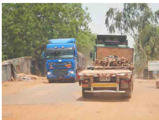
Détérioration des chaussées due aux besoins excessifs en camions lourds
