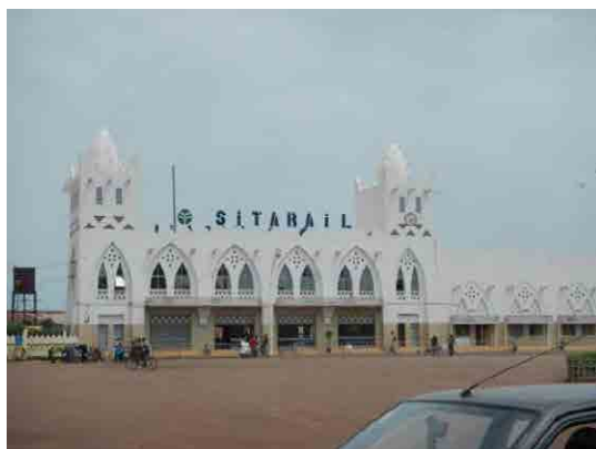
Gare de Bobo Dioulasso
