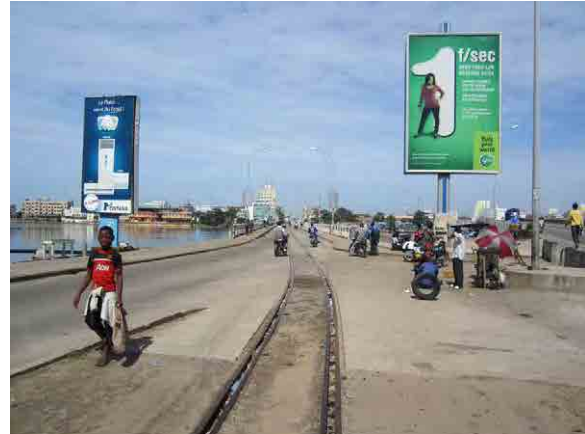
Pont Combiné du chemin de fer et de la route Cotonou, Benin
