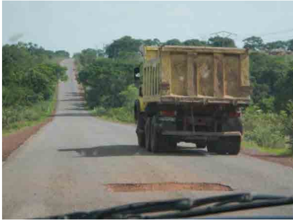
Route avec des nids de poule Bamfora-Niangoloko, Cote d'Ivoire
