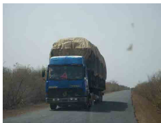
Largeur de la chaussée inadéquate
