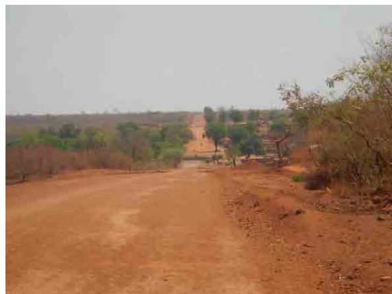
Tronçon en cours de la rehabilitation Bella-Gaya, Niger
