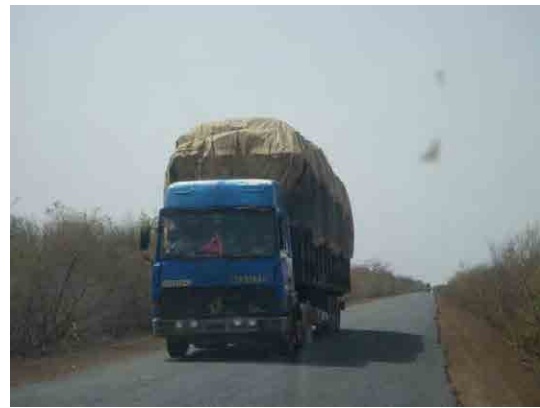
道路幅員が十分でない
