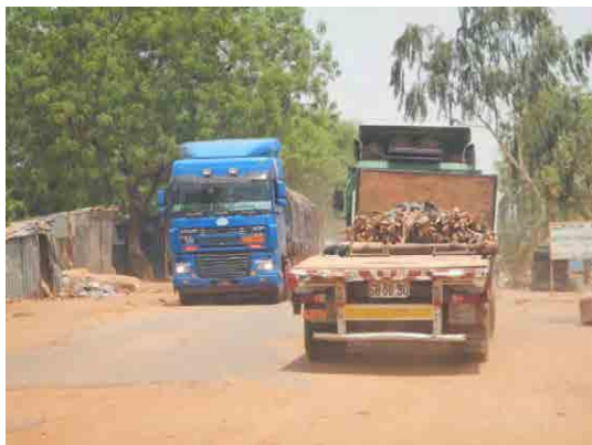
貨物車の往来が激しく舗装が劣化
