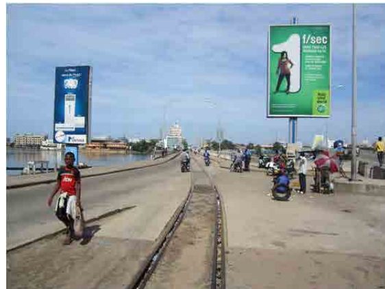
道路・鉄道の併用橋
