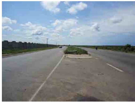
海岸道路、整備区間 ベナン
