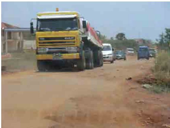
海岸道路、未整備区間 トーゴとの国境付近、ガーナ
