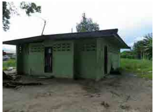
町内市場の北側に位置する公衆トイレ。浄化槽と浸透ますがある施設裏手は悪臭が漂う
