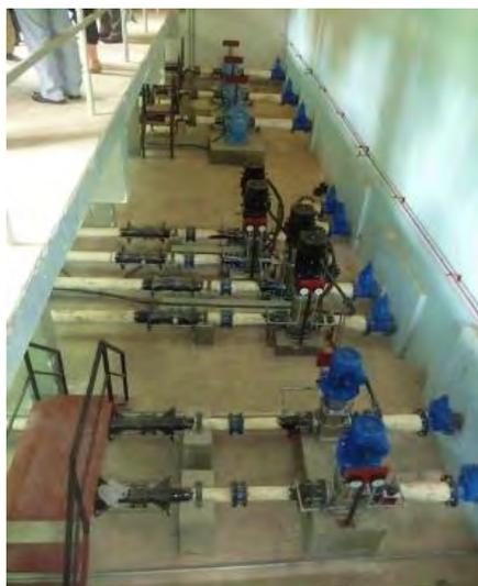
プロジェクトの管理事務所で説明を受けた後、JA-ELA地区の配水場を視察した。ポンプ室に隣接する配水地と高台に配水地を持っている施設で、第1ステージから続いている事業で、第2ステージの事業として、ポンプの設置、配水管の建設が行われた。日本製のポンプが導入されていた。
