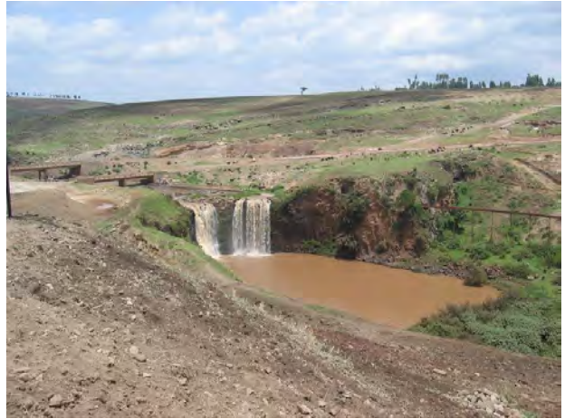
重力式灌漑サイト（カタール）
