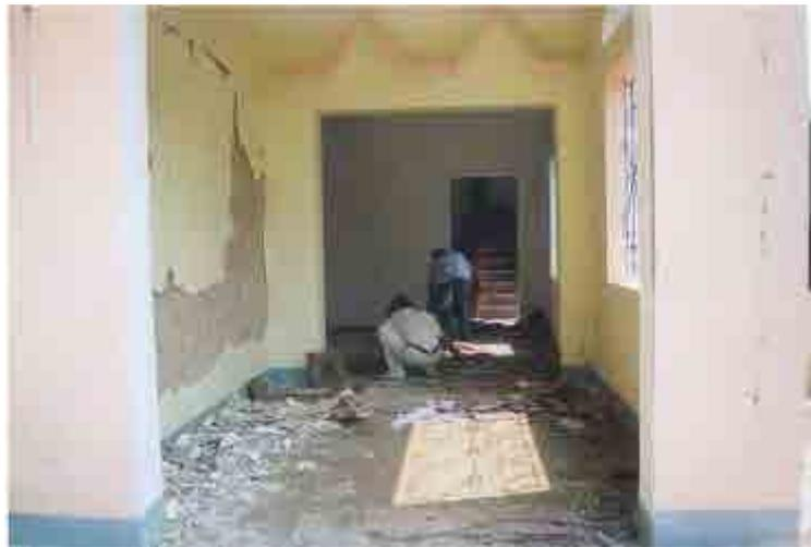
図 4.2.2-3 2001年2月19日の Dien Bien Phu (DBP) 地震による市内の石・レンガ造りの建物被災状況 (出典: IBST セミナー資料)
