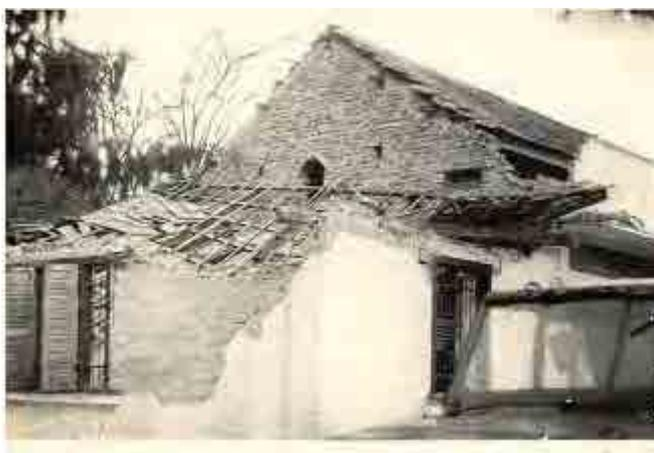
図 4.2.2-1 1983 年 6 月 24 日の Tuan Giao 地震による家屋倒壊写真
