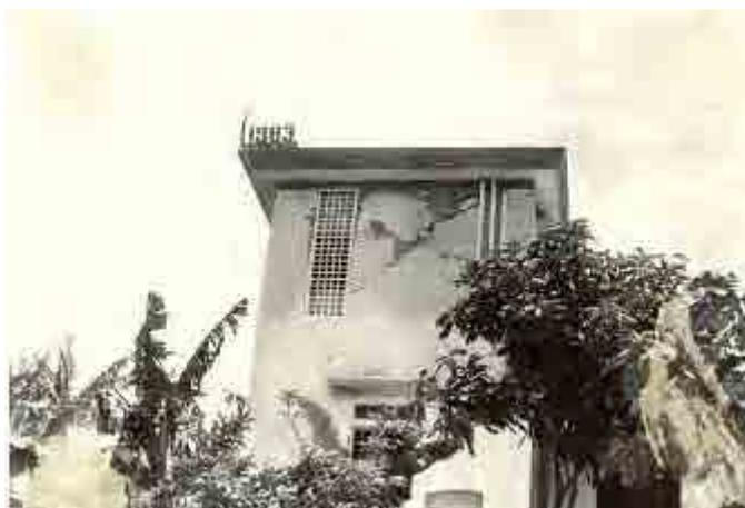
図 4.2.2-2 1983 年 6 月 24 日の Tuan Giao 地震による家屋倒壊写真
