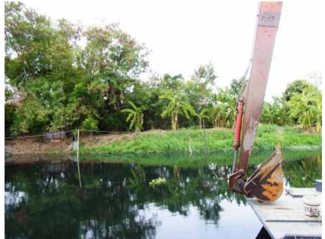
サイト北側境界は川になっている
