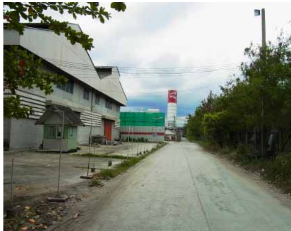
南側は幹線道路と接続しており、敷地内に セメントプラントがある
