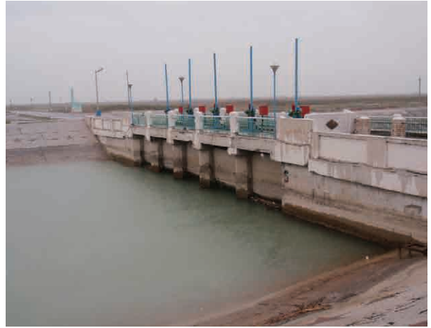
主に Djizak 州に送水する South Mizachul Left Bank Canal の分水工
