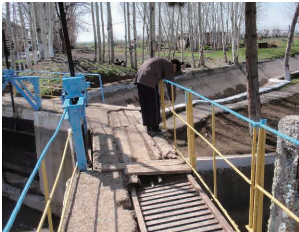
ISD 職員が、灌漑期に備え、ゲート等を塗装している
