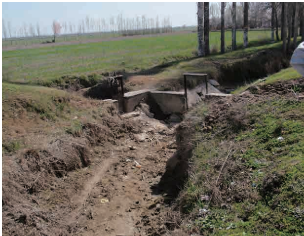
Internal canal の平均的な分水ゲートの状況
