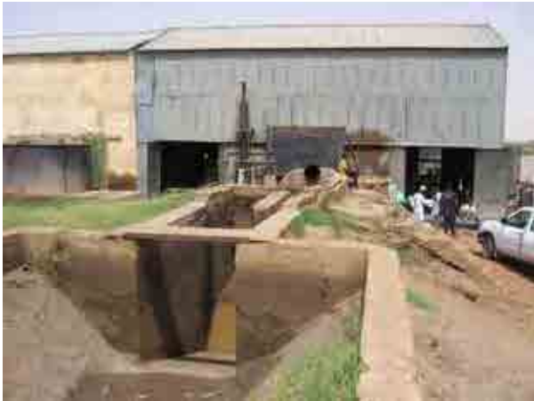
スキーム：Aliab 標題：ポンプ場建屋 日付：2010年8月7日
