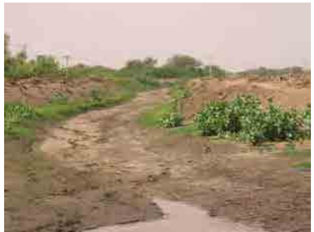
スキーム：Sayal 標題：メイン用水路（ポンプ吐出水槽の直下流） 日付：2010年8月7日
