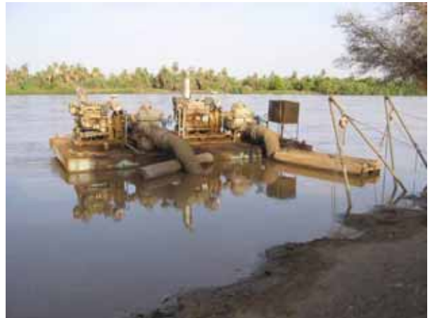
スキーム：Bena 標題：ディーゼルポンプ（フローティング） 日付：2010年8月26日
