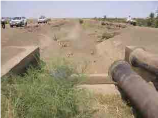
スキーム： Akad & Saroog 標題： メイン用水路（ポンプ吐出水槽の直下流 / 水路底勾配に施工不具合があるとのこと） 日付： 2010年8月27日
