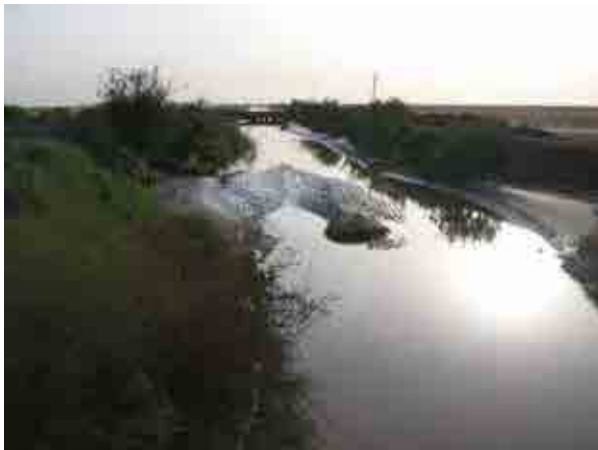
スキーム：Bena 標題：メイン用水路（ポンプ吐出水槽の直下流） 日付：2010年8月26日
