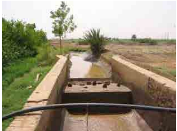
スキーム：Aliab 標題：メイン用水路（ポンプ吐出水槽の直下流） 日付：2010年8月7日
