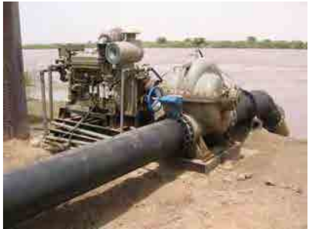
スキーム：Aliab 標題：ディーゼルポンプ（屋外半固定型） 日付：2010年8月7日
