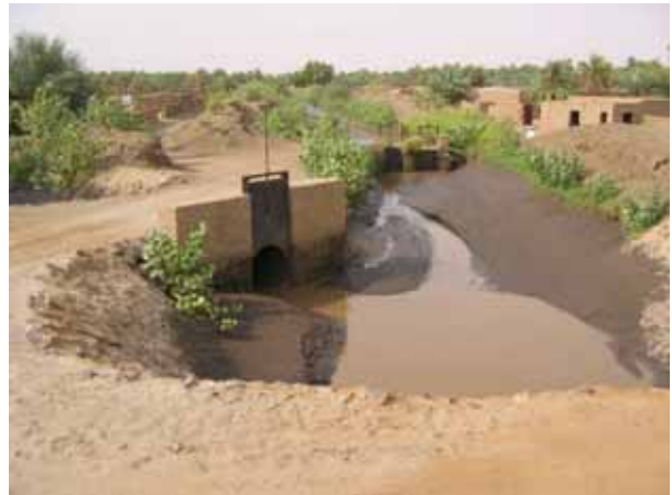
スキーム：Bauga 標題：メイン用水路（マイナー用水路への分土工） 日付：2010年9月1日
