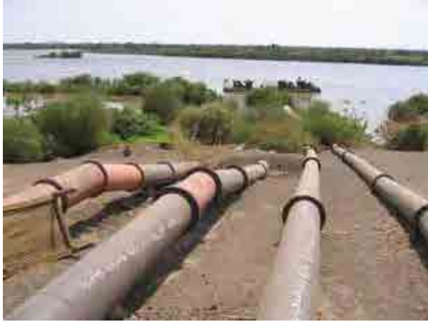
スキーム： Akad & Saroog 標題： フローティングポンプ及び吐出管 日付： 2010年8月27日
