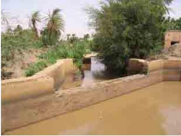
スキーム：Kitiab 標題：メイン用水路（ポンプ吐出水槽の直下流） 日付：2010年9月2日
