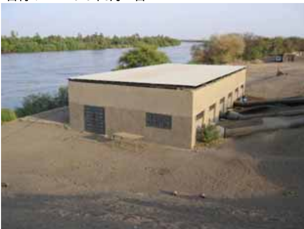
スキーム：Bena 標題：ポンプ場建屋 日付：2010年8月26日
