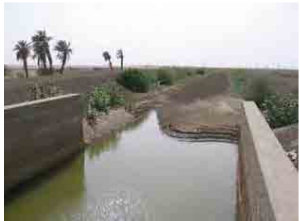
スキーム：Zaorat 標題：メイン用水路（ポンプ吐出水槽の直下流） 日付：2010年8月10日
