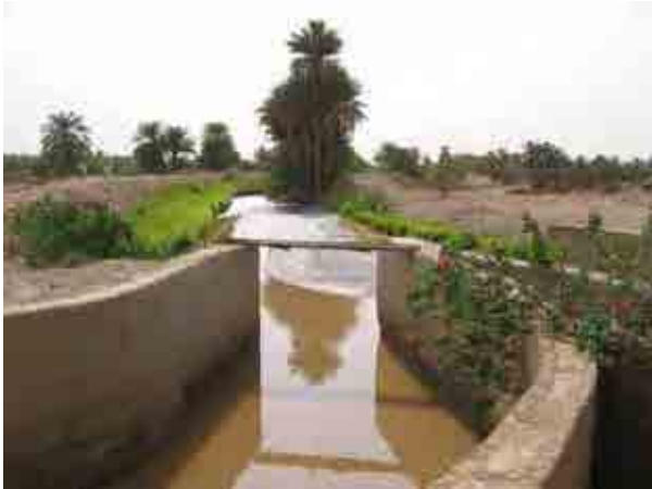
スキーム：Bauga 標題：メイン用水路（ポンプ吐出水槽の直下流） 日付：2010年9月1日
