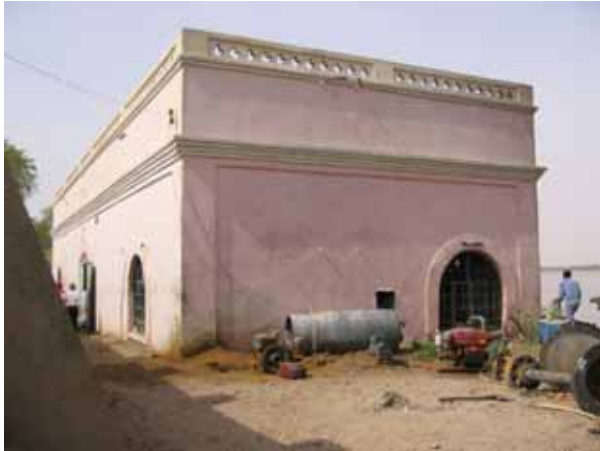
スキーム：Bauga 標題：ポンプ場建屋 日付：2010年9月1日
