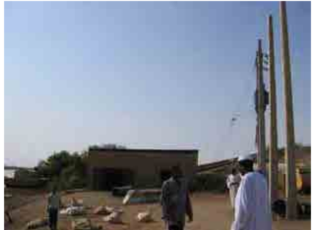
スキーム： Korba 標題： ポンプ場建屋 日付： 2010年8月27日
