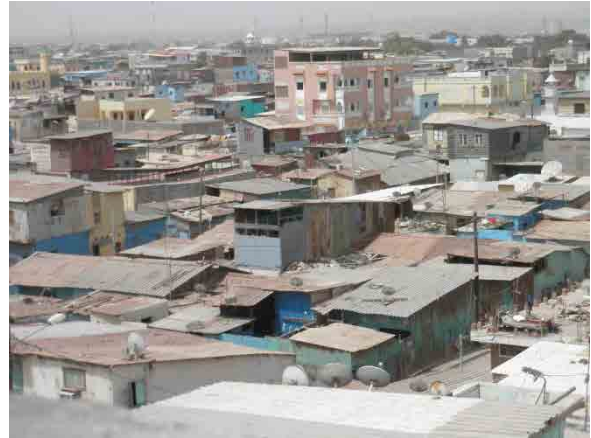
住宅密集地の状況。隣戸との間隔がほとんど無く連続しており、延焼危険が大きい。
