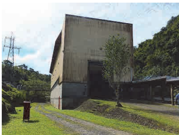
写真5-1 ワイロア発電所
