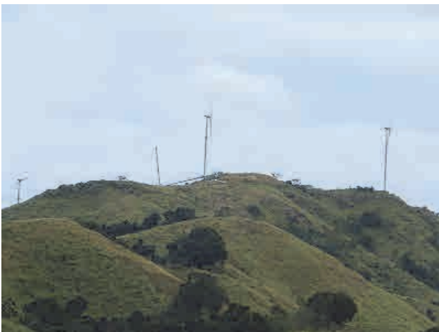
風車の設置・稼働状況
