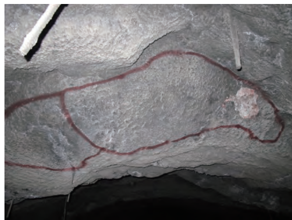
写真－ 72 対策実施箇所のマーキング状況
