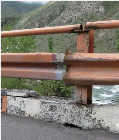
写真－ 68 No. 4 橋 高欄
