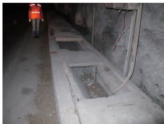
写真－ 77 コンクリート蓋の状況
