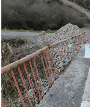
写真－ 69 No. 13 橋 高欄
