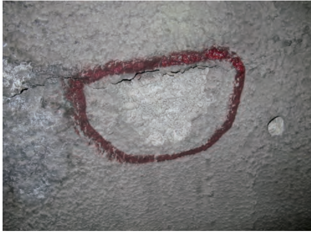
写真－ 71 対策実施箇所のマーキング状況
