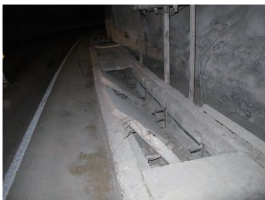
写真－ 77 コンクリート蓋の状況
