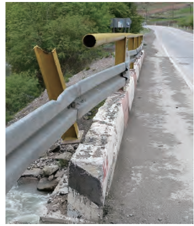
写真－ 70 No. 14 橋 高欄
