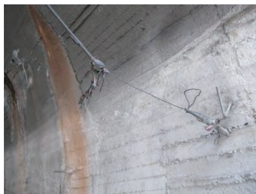
写真－ 73 起点側坑付近のケーブル垂れ下がり状況
