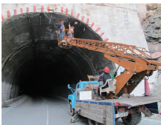
写真－ 11 トンネル点検状況
