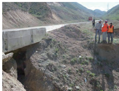
写真-5 DEP30 現地立会い状況 (左端 DEP30 主任管理担当者)
