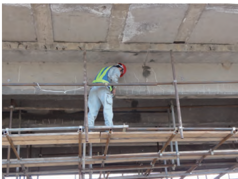
写真－ 6 No. 6 橋での調査（1）
