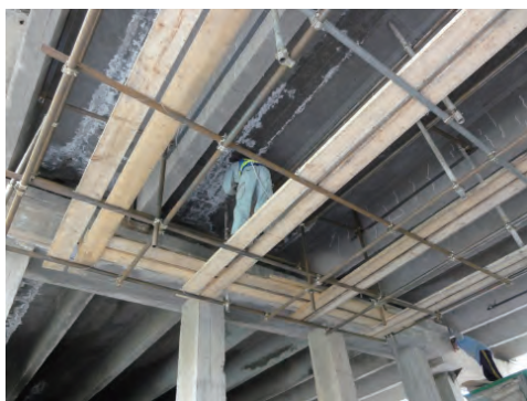
写真－ 8 No.17 橋での調査 (1)
