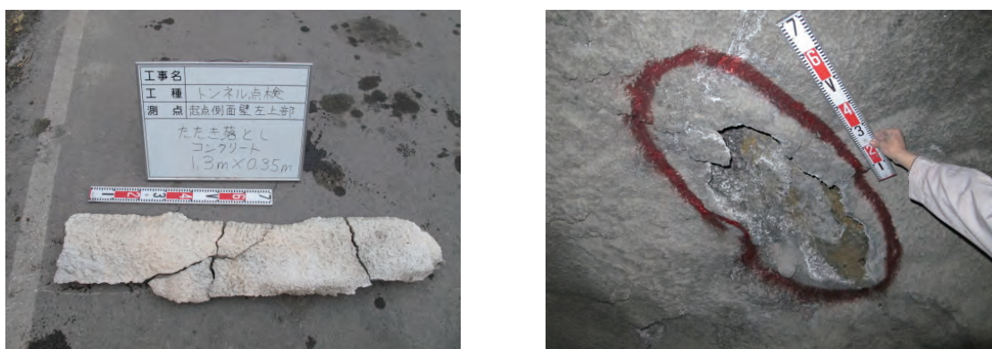
写真-14 たたき落とししたコンクリート及びマーキングの実施例
