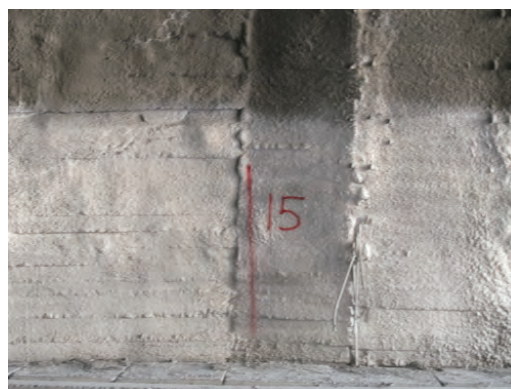
写真－ 12 トンネルマーキング状況
