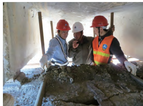
写真－ 7 No. 6 橋での調査（2）
