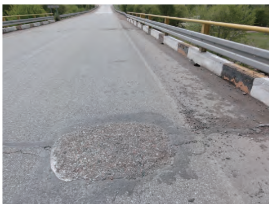
写真－ 26 No. 6 橋 伸縮装置部の舗装 ポットホール補修後
