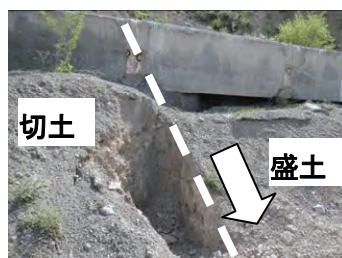
写真-21 切盛境界スベリ破壊による段差(D45)
