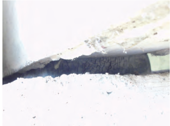
写真－ 35 No. 17 橋 ゴム製支承 膨らみ、ひび割れ
