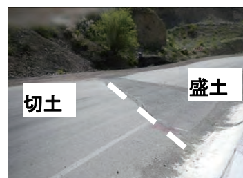
写真-21 切盛境界スベリ破壊による段差(D45)
