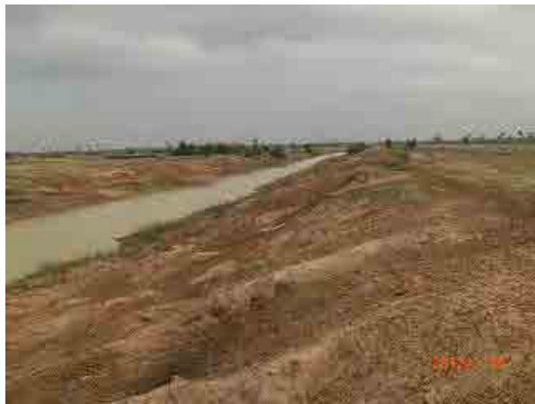
工事に放棄された NS-78 用水路 (両岸は水田)
