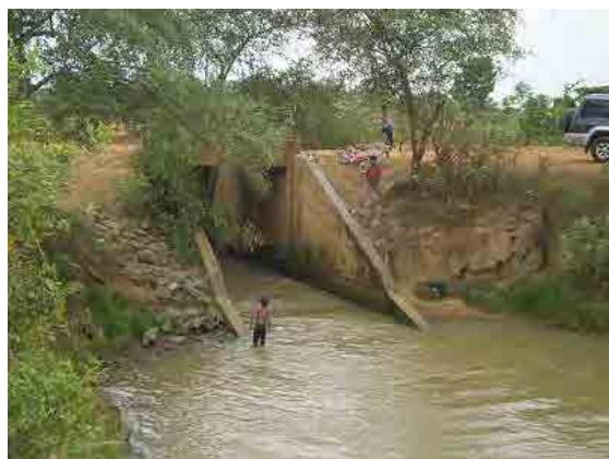
Vat Krouch 取水工 (下流側より撮影)
