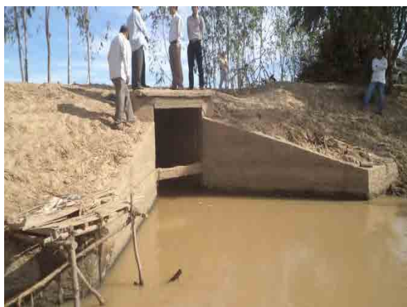
貯水池堤防の取水カルバート
