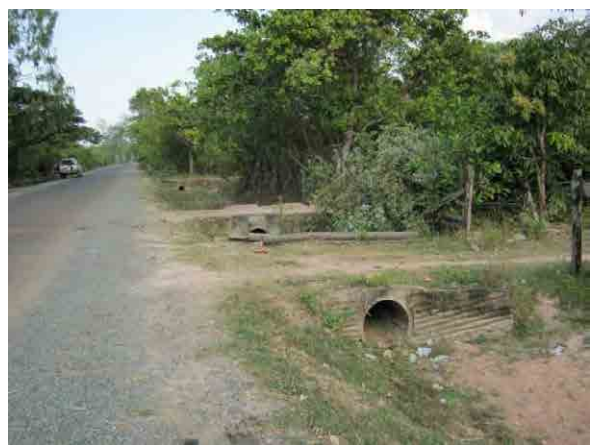
幹線用水路上のカルバート
