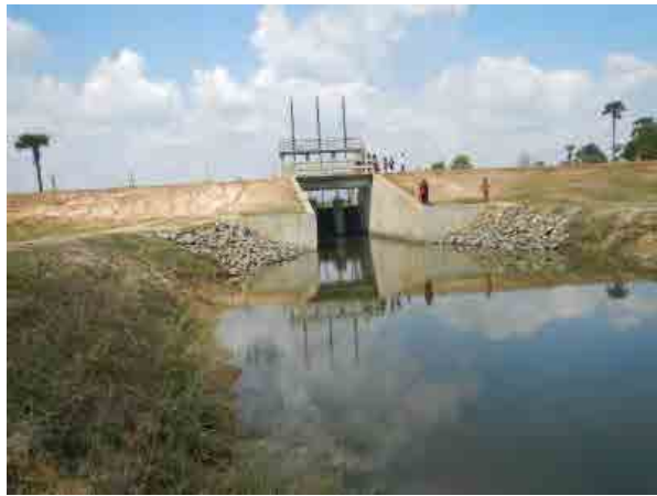
Khprob Krous 貯水池の取水工
