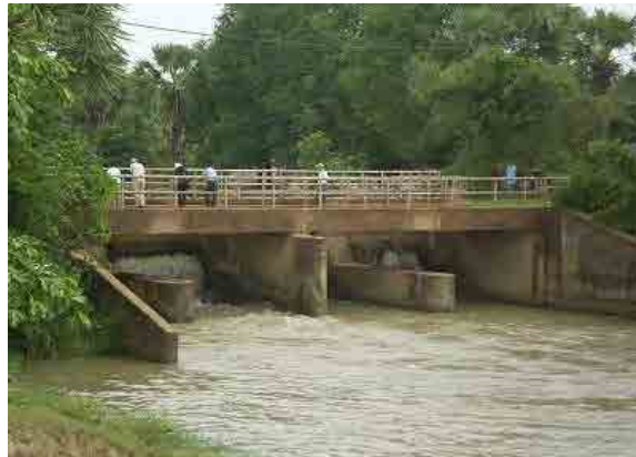
Andong Sla 取水工 (下流側より撮影)
