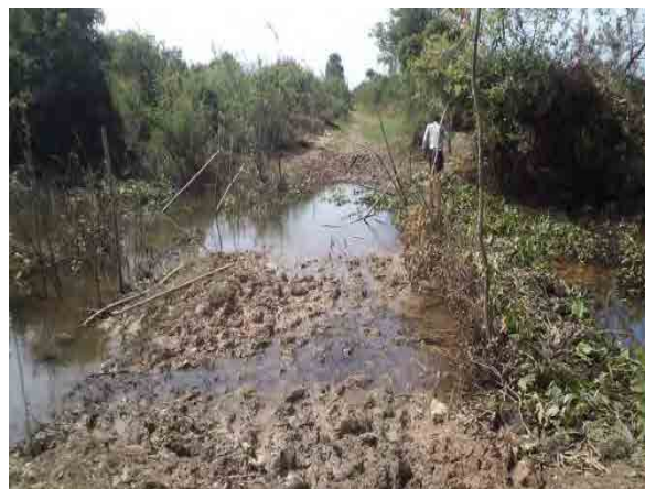
スラズランバイ貯水池堤防 (改修前)
