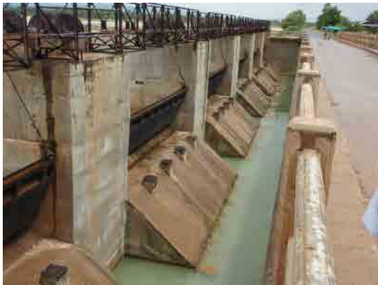
改修された Kpob Trobek 貯水池の余水吐
