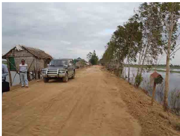
スラズランバイ貯水池堤防 (改修工事後)
