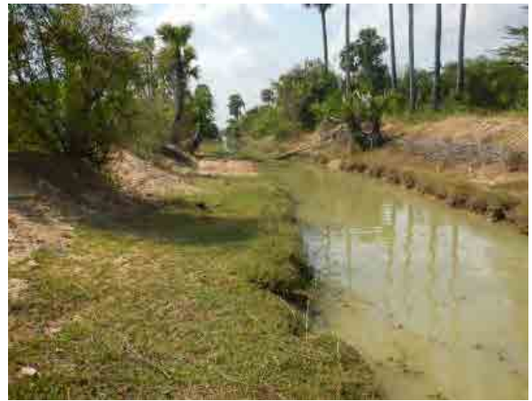
幹線用水路 35 (Khprob Krous 貯水池付近)
