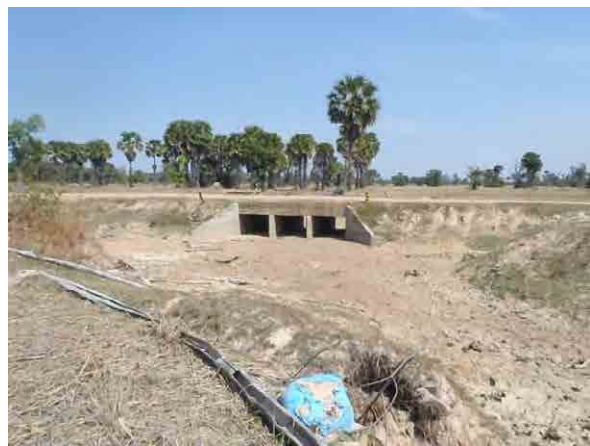
幹線用水路及びカルバート
