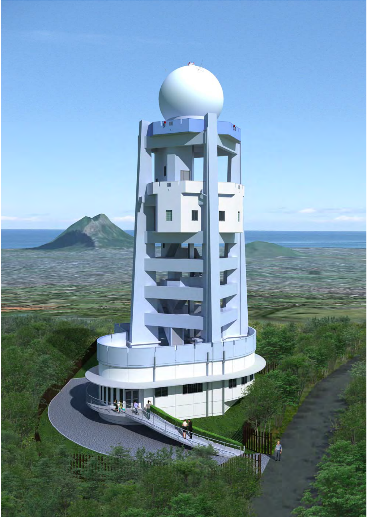
トウル・オ・セルフ気象レーダー塔施設
