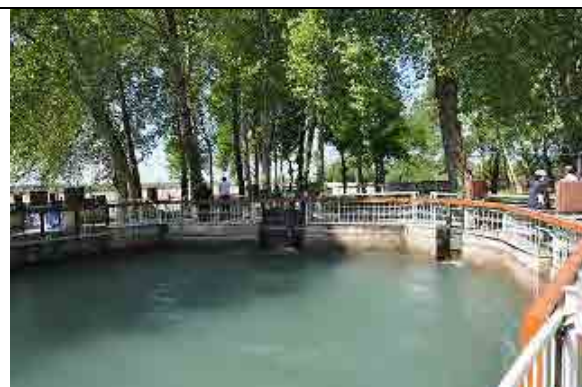
Вододелитель канала Shorobod
