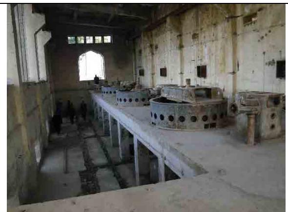
Здание ГЭС (внутри)
