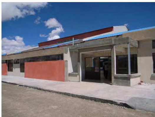
El estado actual del Aeropuerto de Uyuni. Está operando sólo con la estructura en el momento de estudio en 2012.
