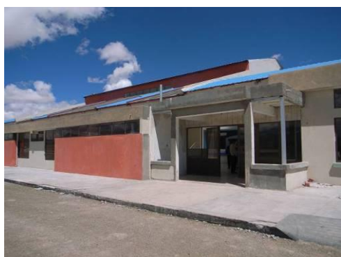
ウユニ空港ターミナルの現況。2012年の調査時点では躯体のみで運用されている。
