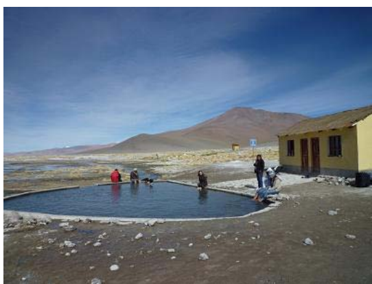
日本政府の草の根無償資金協力による道の駅と隣接する温泉施設
