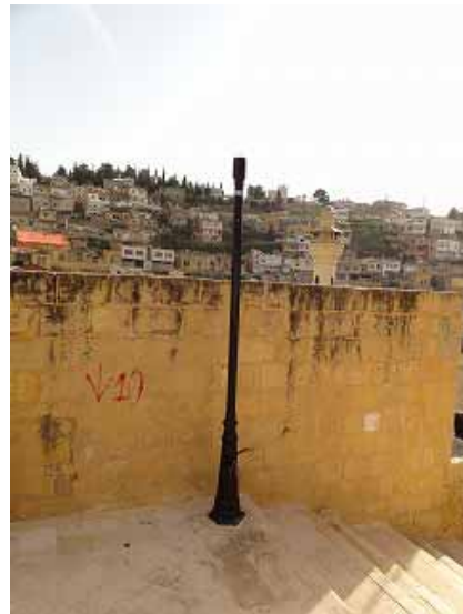
ことごとく破壊された街灯
