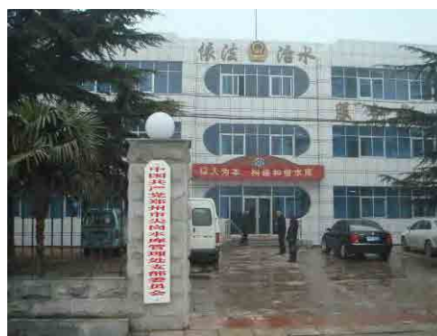
鄭州市尖崗ダム管理所
