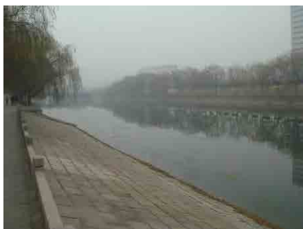
護岸工事された東風渠
