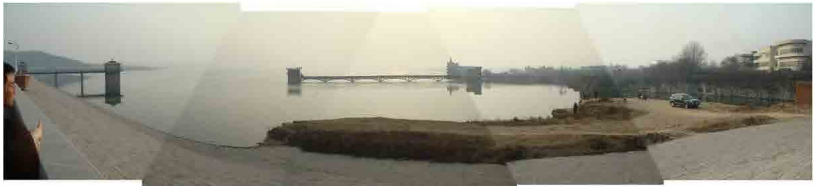
萌山ダム貯水池
