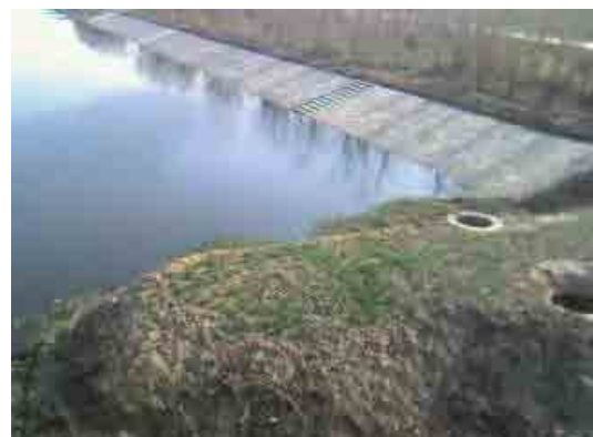
河道内に残された盛土（水道管が埋設）
